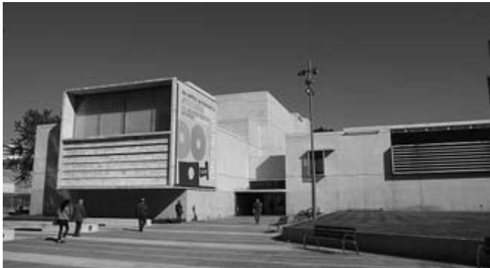
Edificio de Civican en Pamplona
