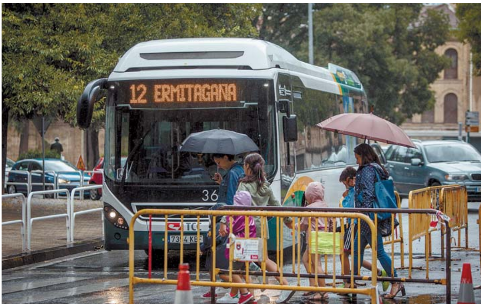
Una villavesa circula por la calle Navas de Tolosa, una de las zonas sometidas a las obras que se están realizando en el centro.
