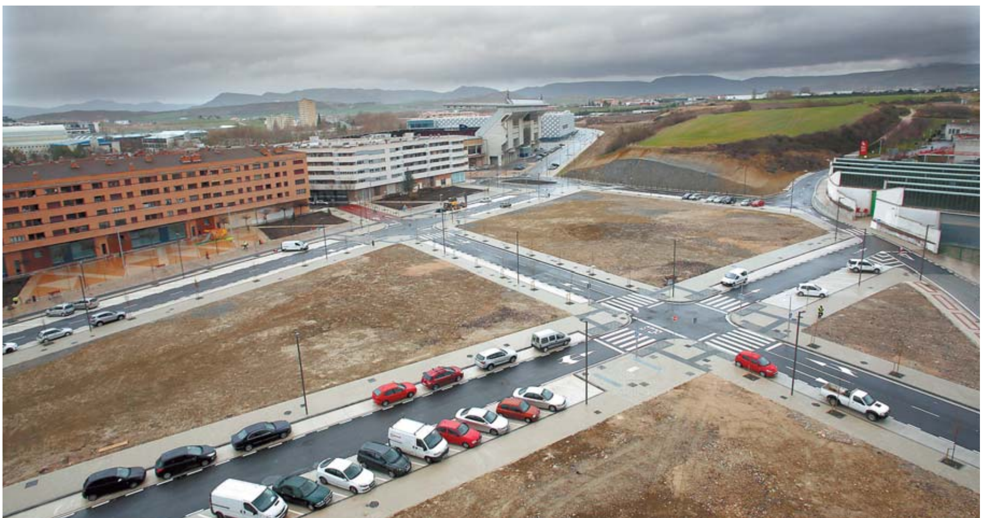
Al fondo a la izquierda, el estadio El Sadar y delante una calle de nueva creación. A la derecha el acceso a la empresa grúas Albur.
