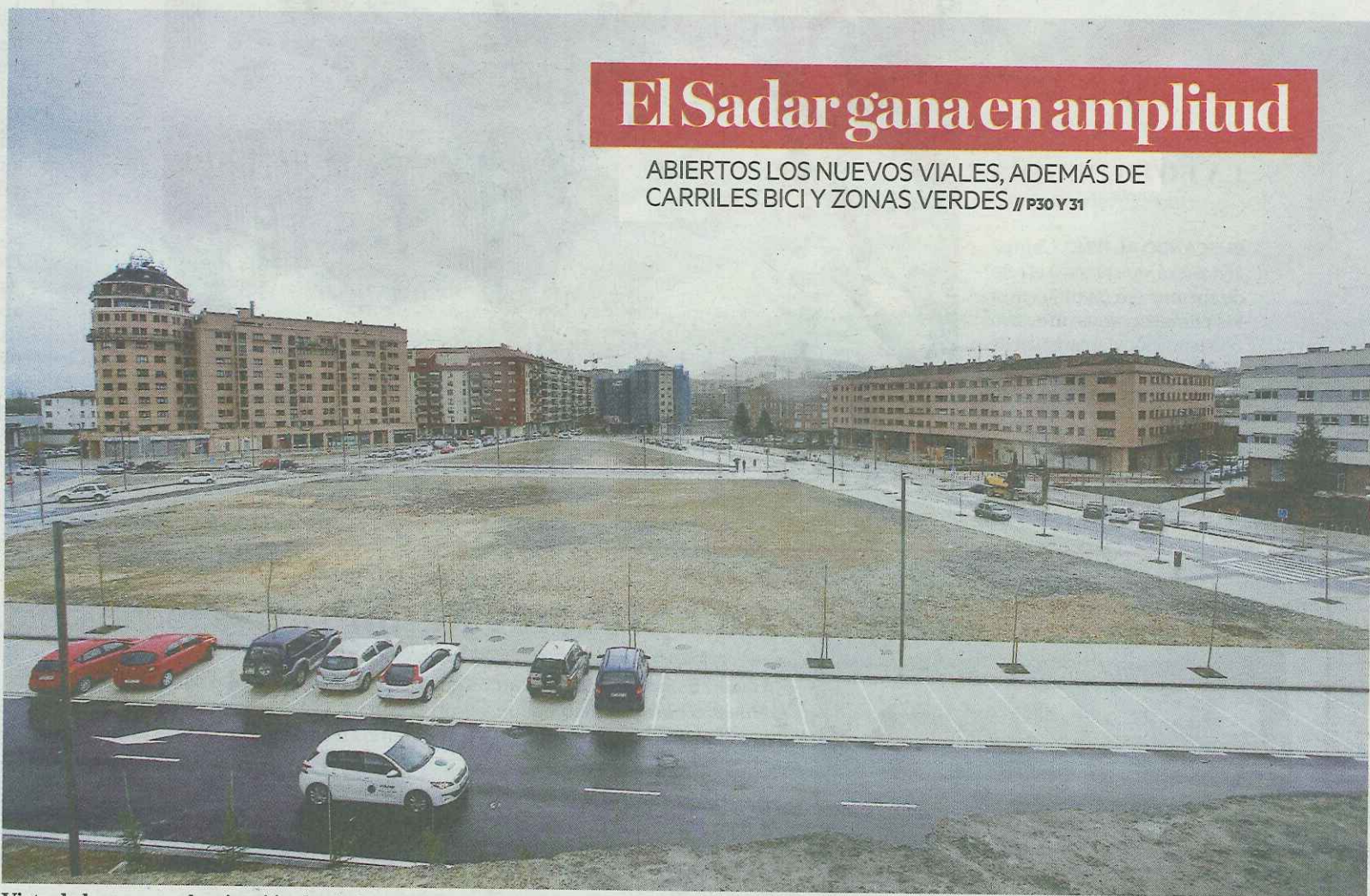
Vista de la nueva urbanización desde la zona próxima al acceso a Pamplona por el sur. Foto: Mikel Saiz
