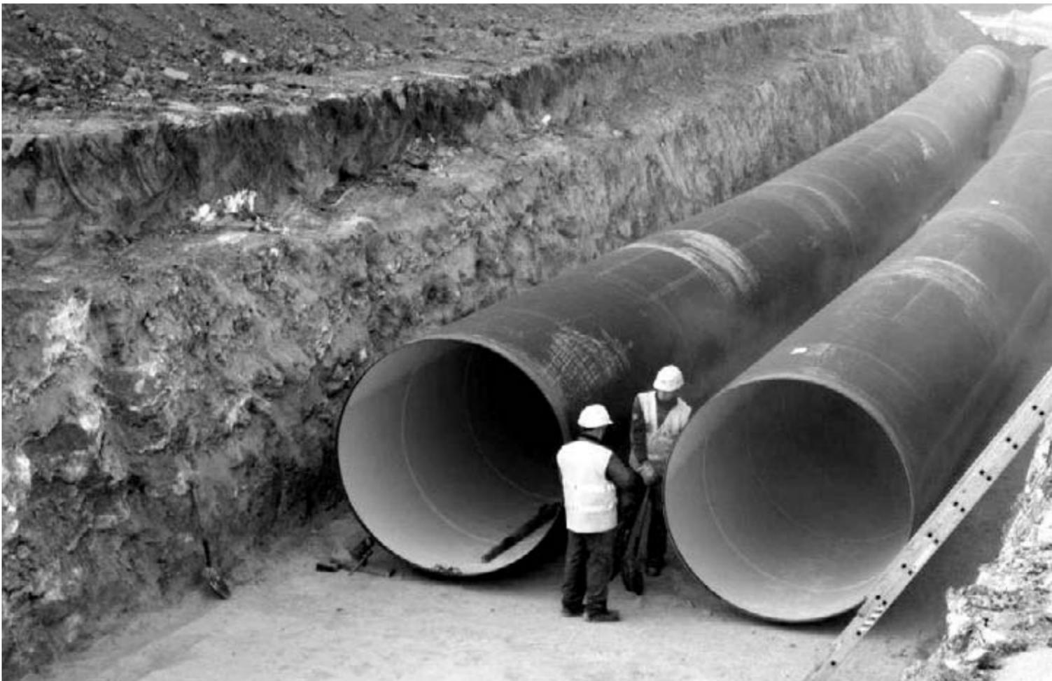
Vista de una zanja con doble tubería en la zona a de la ampliación del Canal de Navarra. El tamaño de los tubos supera al de las dos personas. CANASA
