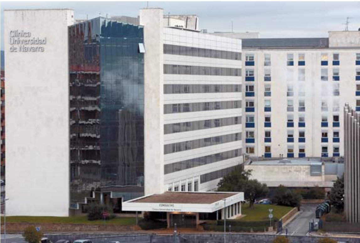
Exterior de la Clínica Universidad de Navarra. ARCHIVO (JOSÉ CARLOS CORDOVILLA)
