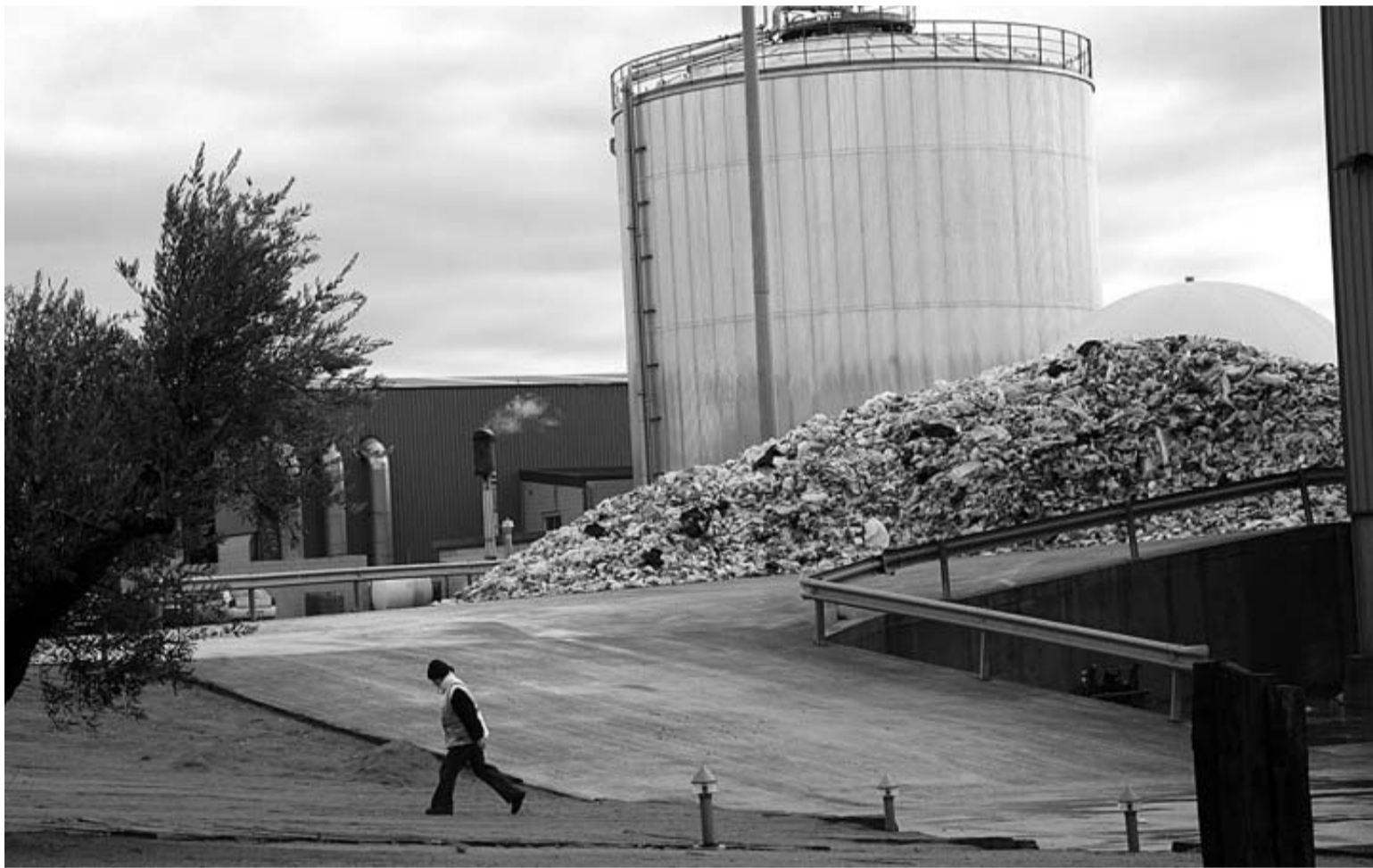
Vista de la planta de tratamiento de residuos de El Culebrete en Tudela.
