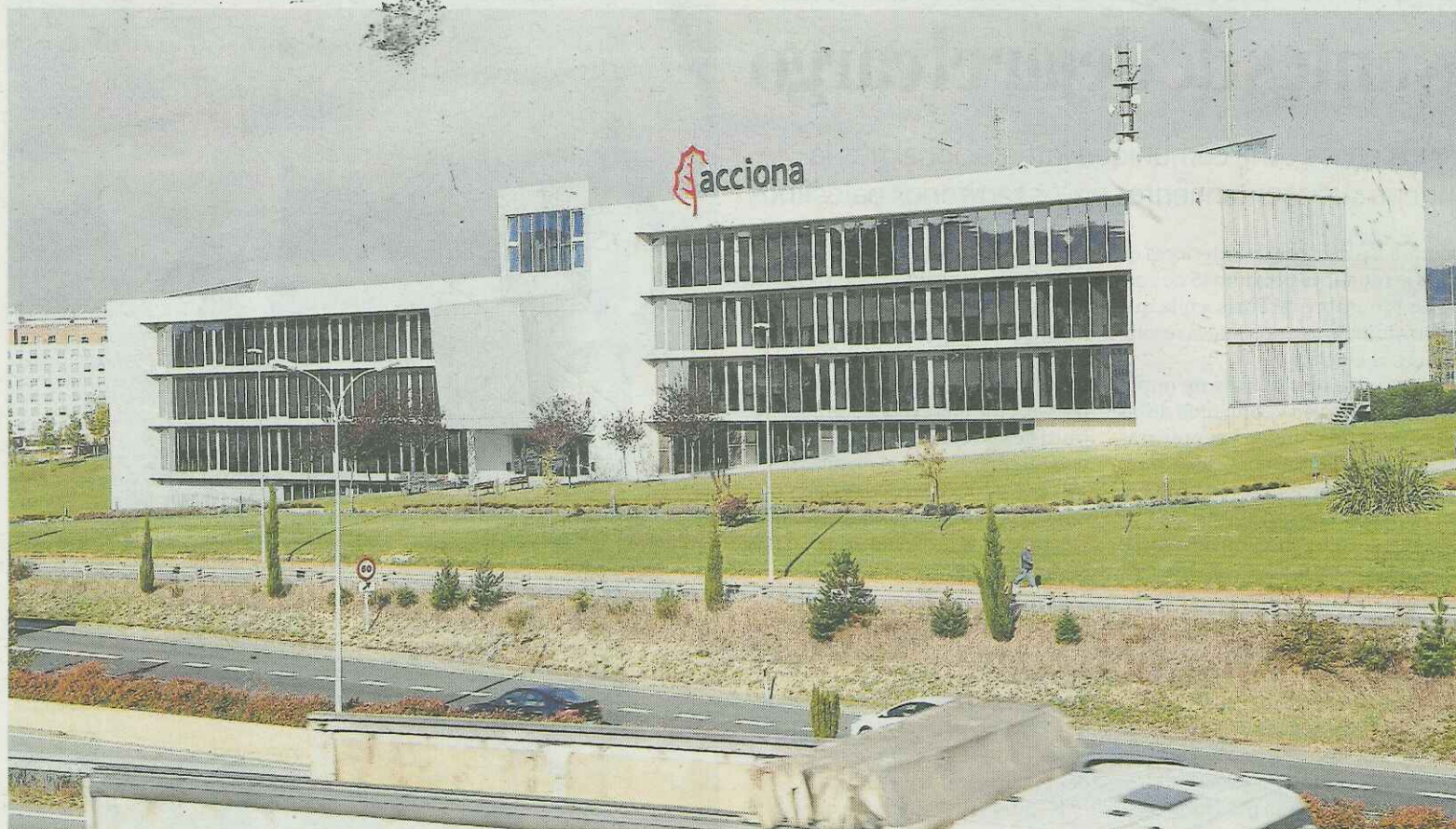
Edificio central de Acciona en Sarriguren.
