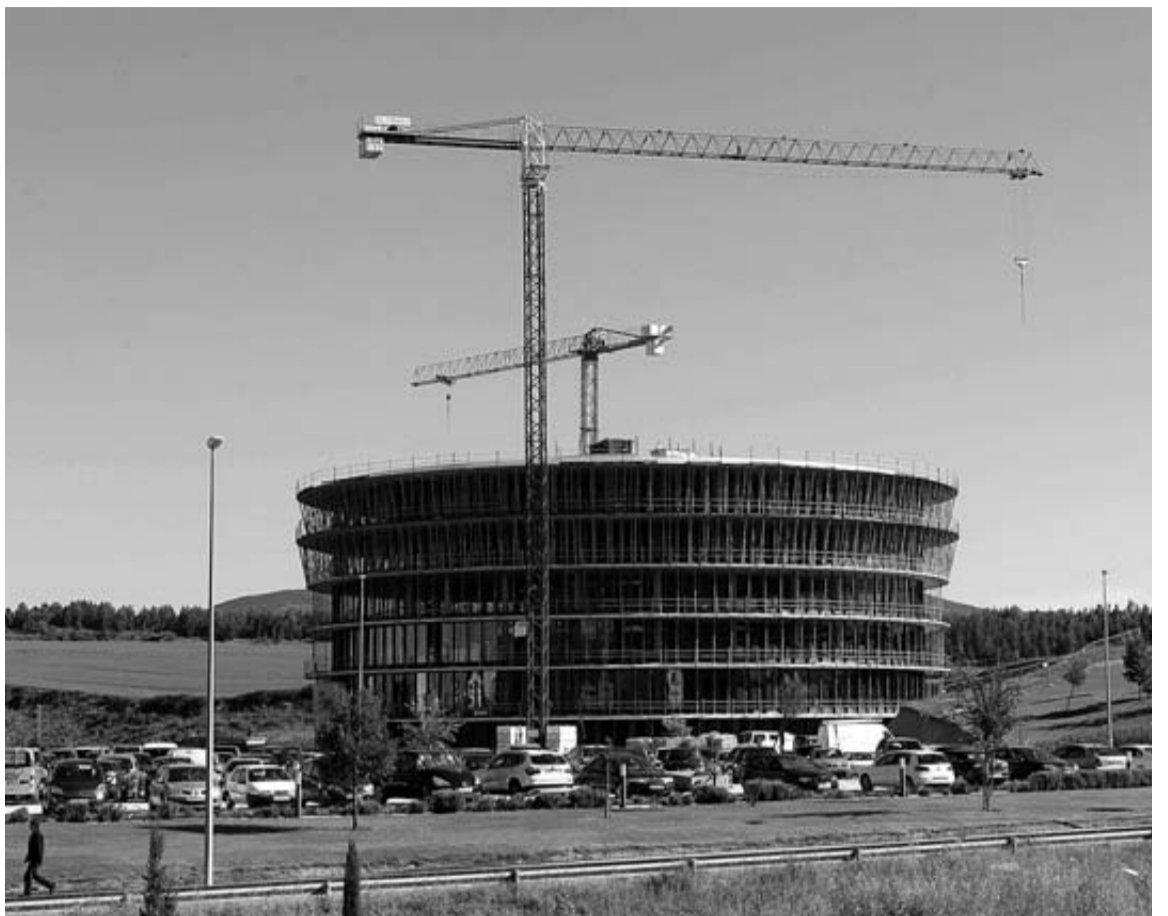
El futuro edificio de Gamesa en Sarriguren con la altura definitiva a falta de rematar con la cubierta. BUXENS
