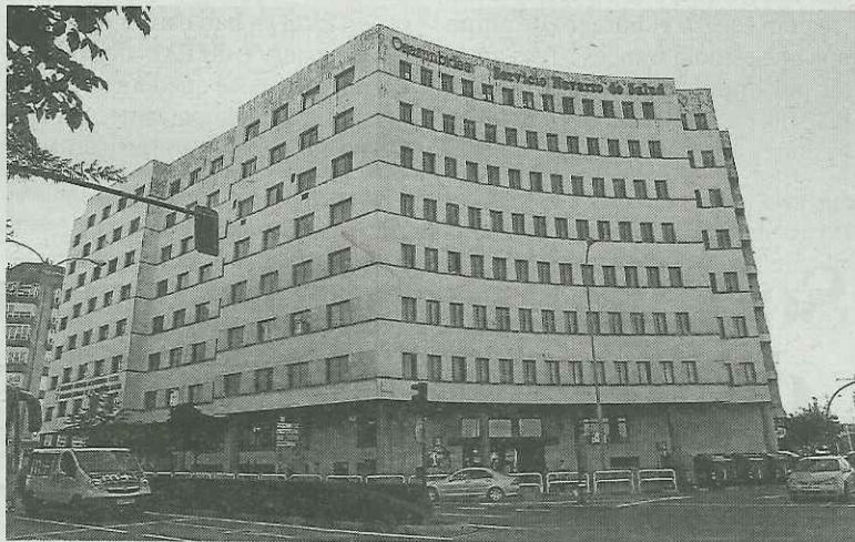
Fachada del edificio del SNS-O. Foto: Oskar Montero
