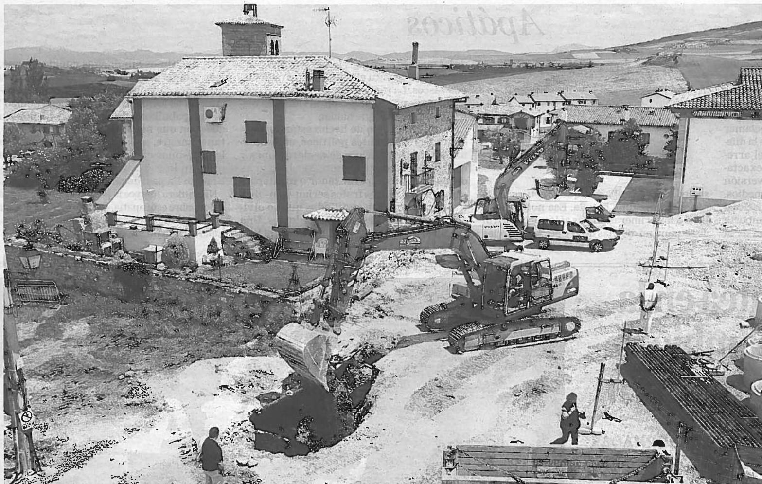
Una excavadora cubre con tierra la zanja en la que se produjo el accidente laboral. FOTO: JAVIER BERGASA
