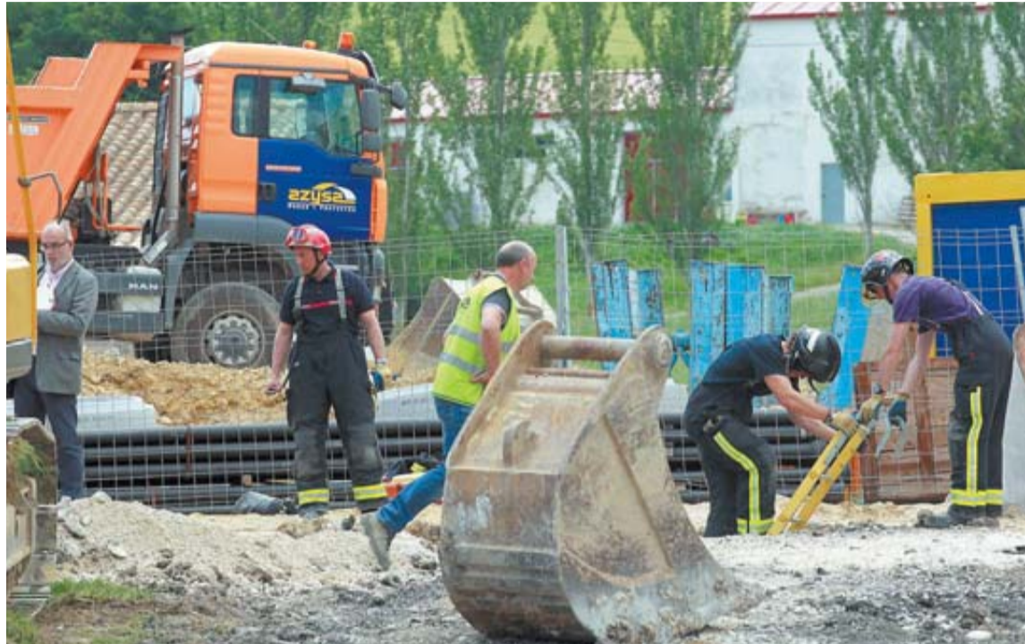
Un bombero desciende al interior de la zanja donde ocurrió el accidente mortal.
