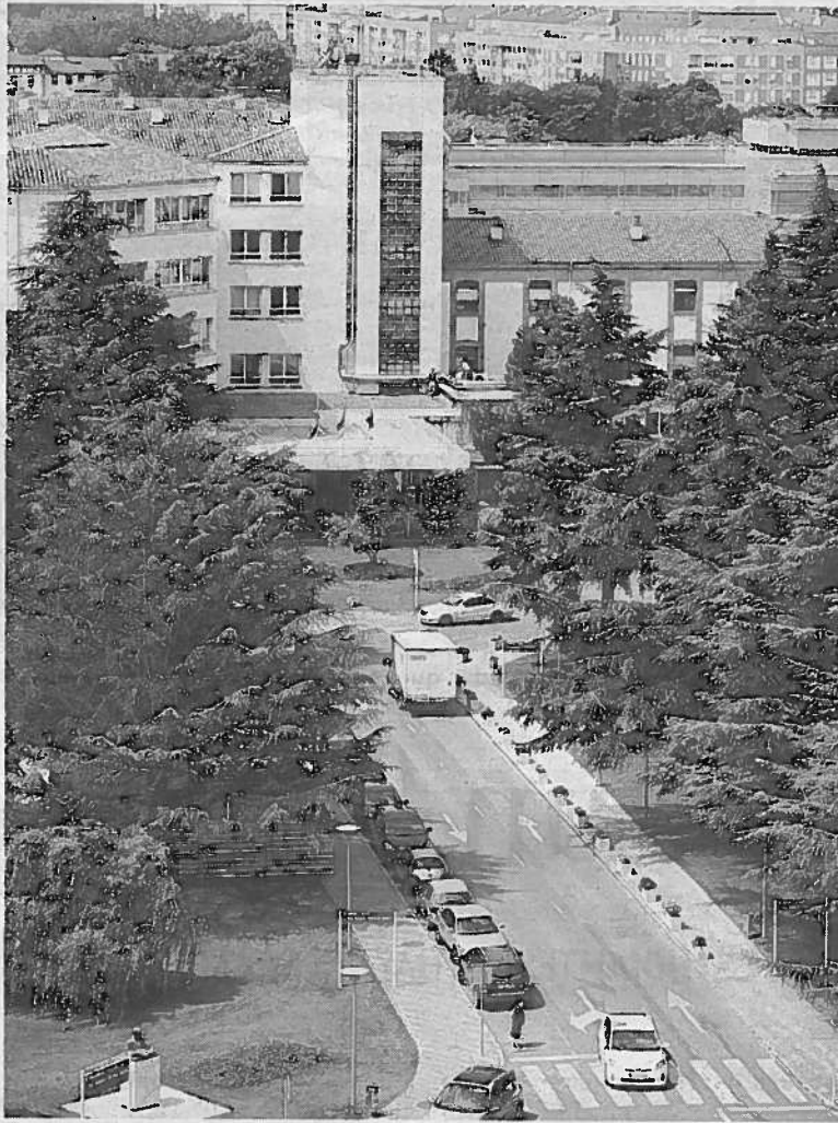
Vista del edificio del Hospital de Navarra, del CHN. FOTO: IÑAKI PORTO
