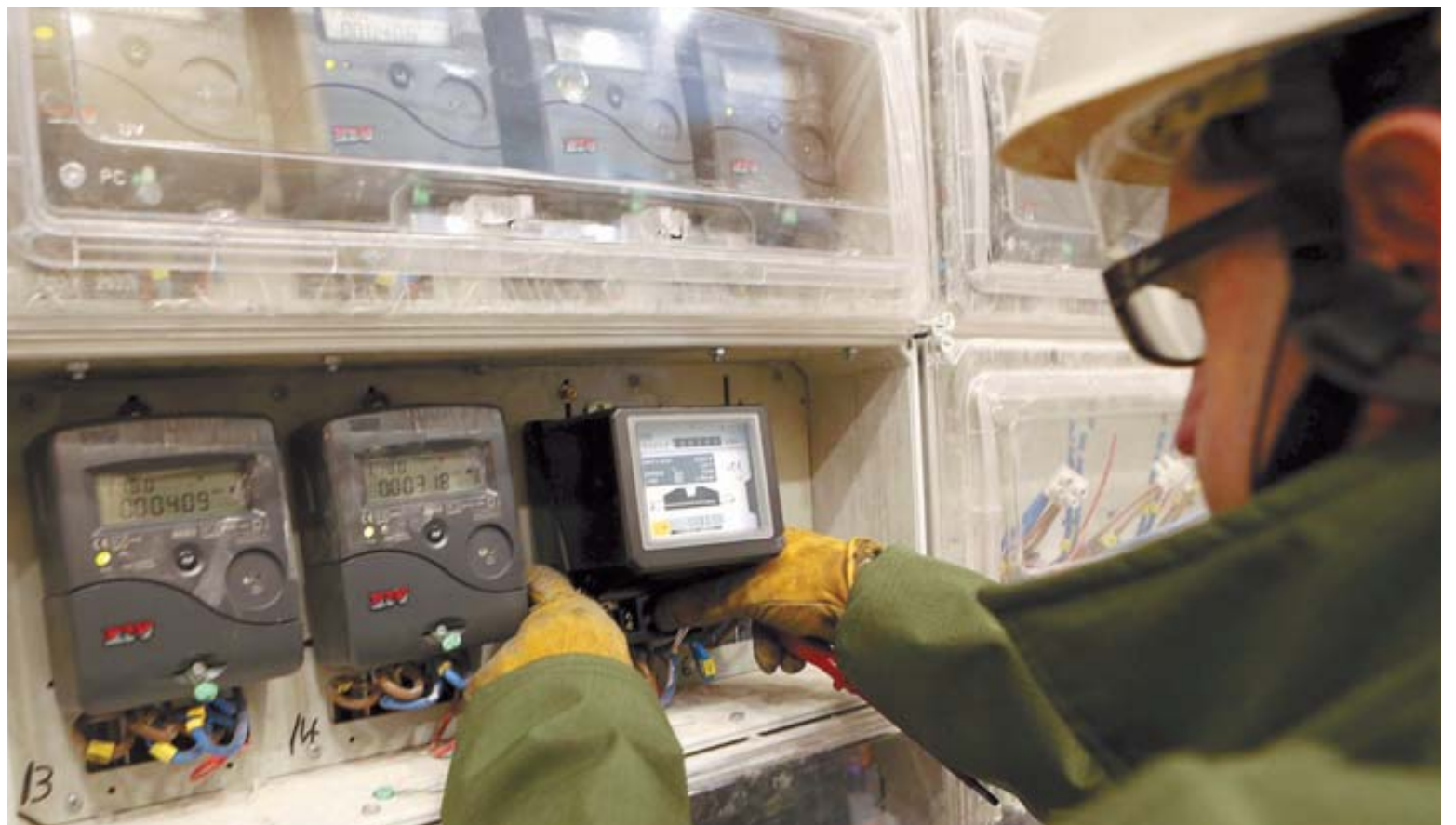
Un operario trabaja con unos contadores de la luz en un bloque de viviendas de Pamplona.
