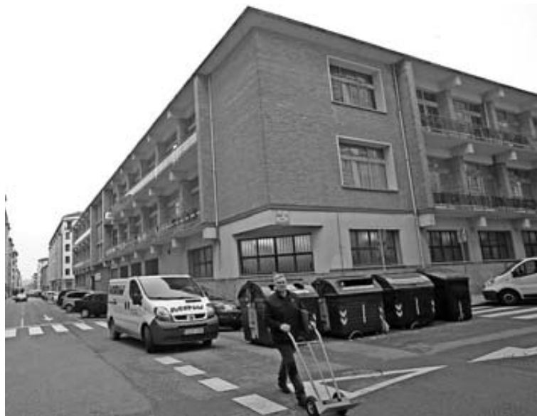
Fachada de la Escuela de Arte de Pamplona.
