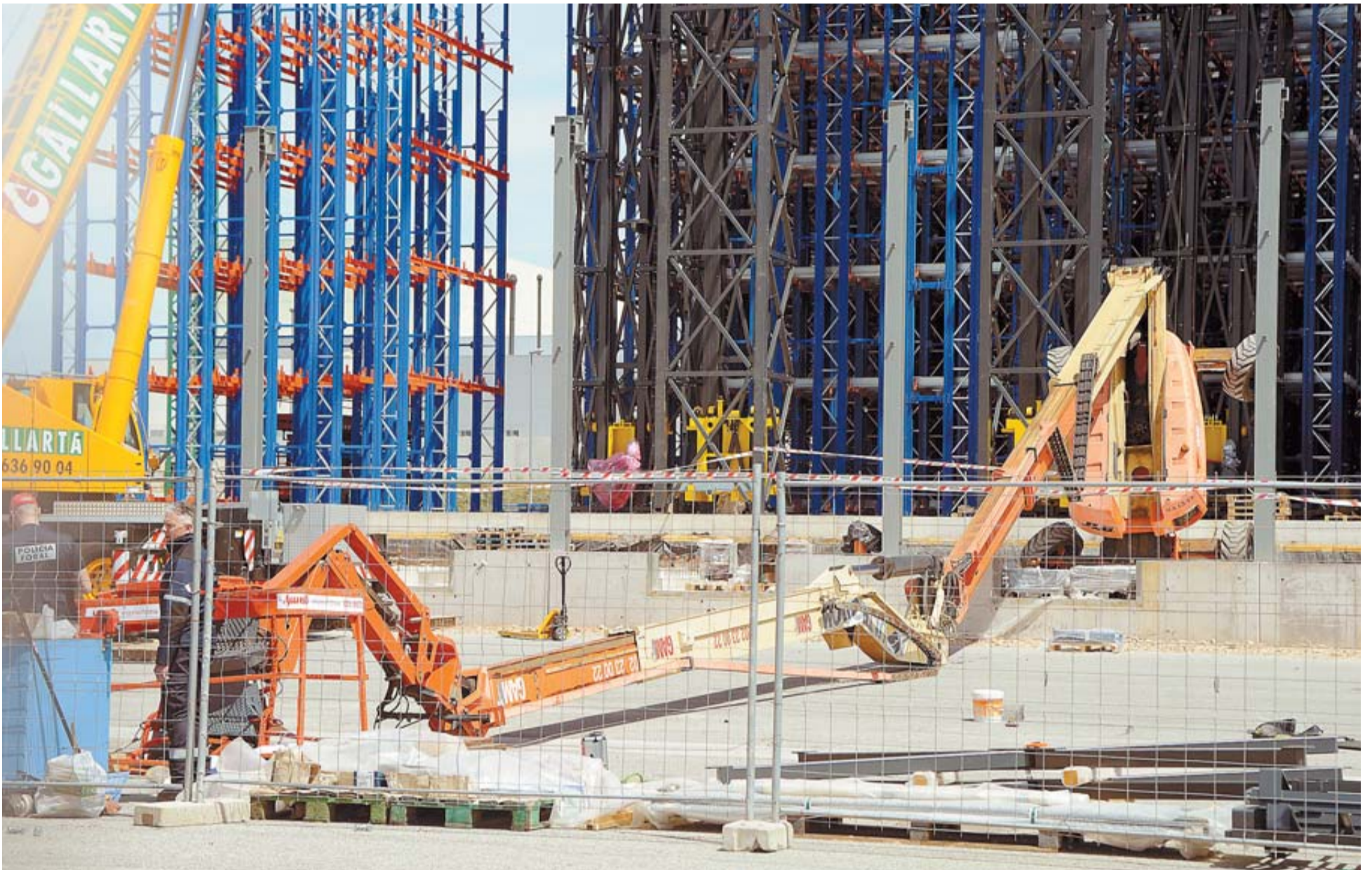
A la izquierda, la cesta en la que estaban subidos los dos fallecidos, que se fue al suelo con el brazo articulado. Al fondo, la plataforma móvil, volcada sobre dos ruedas.
