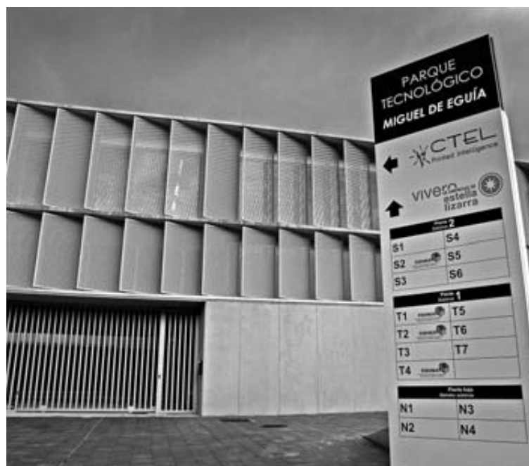
La parte del edificio del centro tecnológico dedicado a vivero está ocupado únicamente por Fidima.
