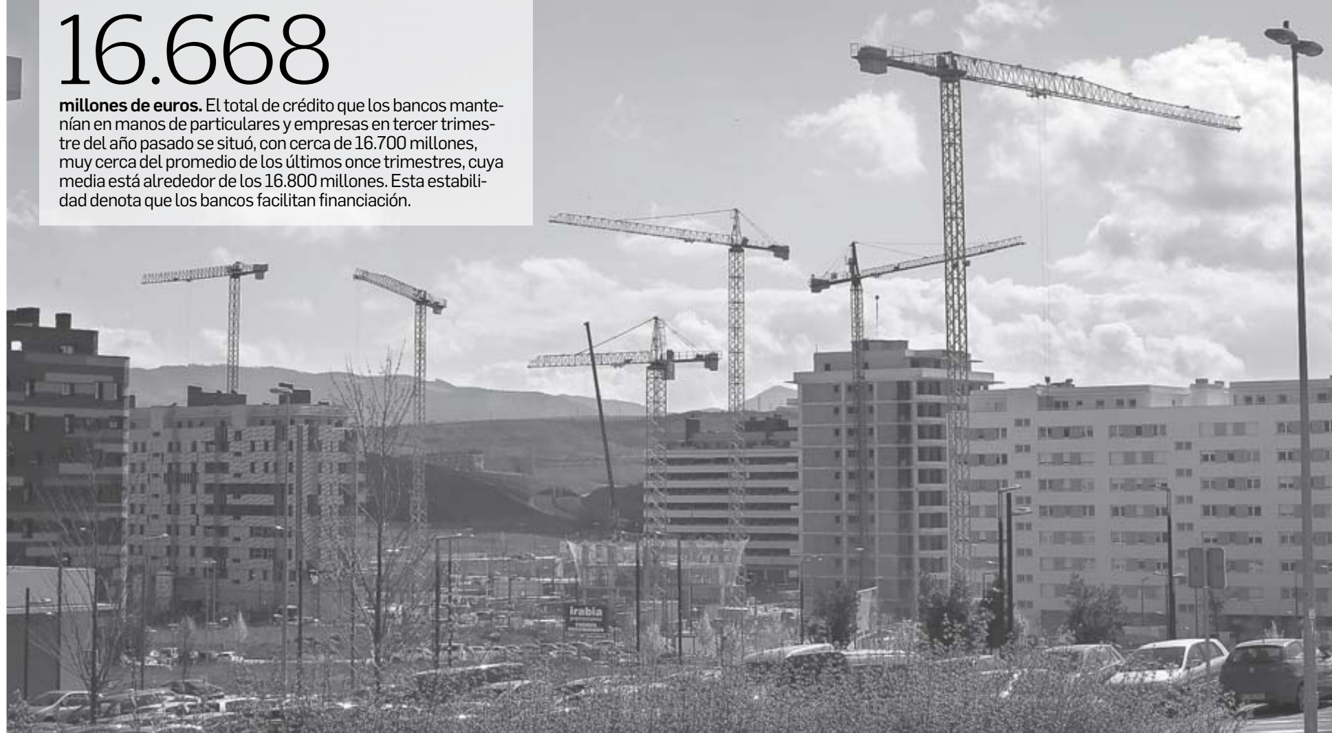
Grúas en el barrio de Lezkairu en Pamplona.
