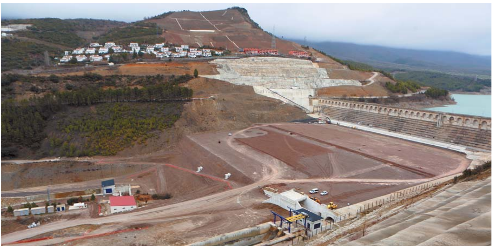
La presa se está construyendo delante de la antigua con materiales sueltos y se ve a la derecha de la foto. La línea recta de vegetación de la izquierda marca la altura máxima que tendrá: 108 metros. Arriba se ve la urbanización de casas que se expropiaron al deslizarse la ladera.
