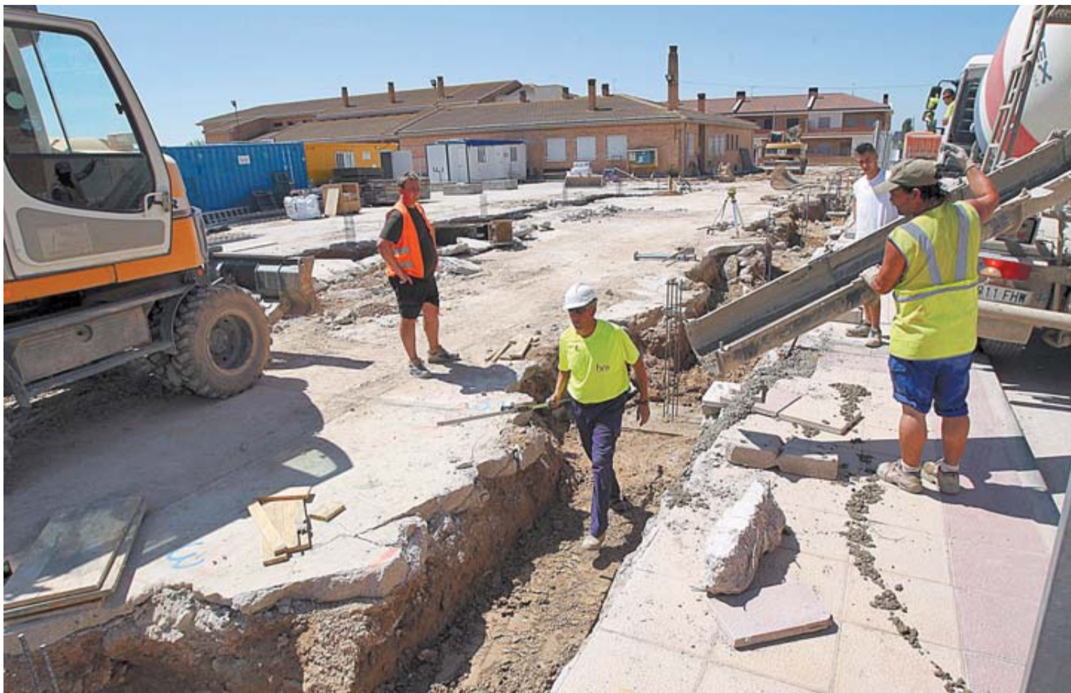
Varios operarios trabajan en la construcción del nuevo edificio que acogerá a los alumnos de Educación Infantil de Arguedas.
