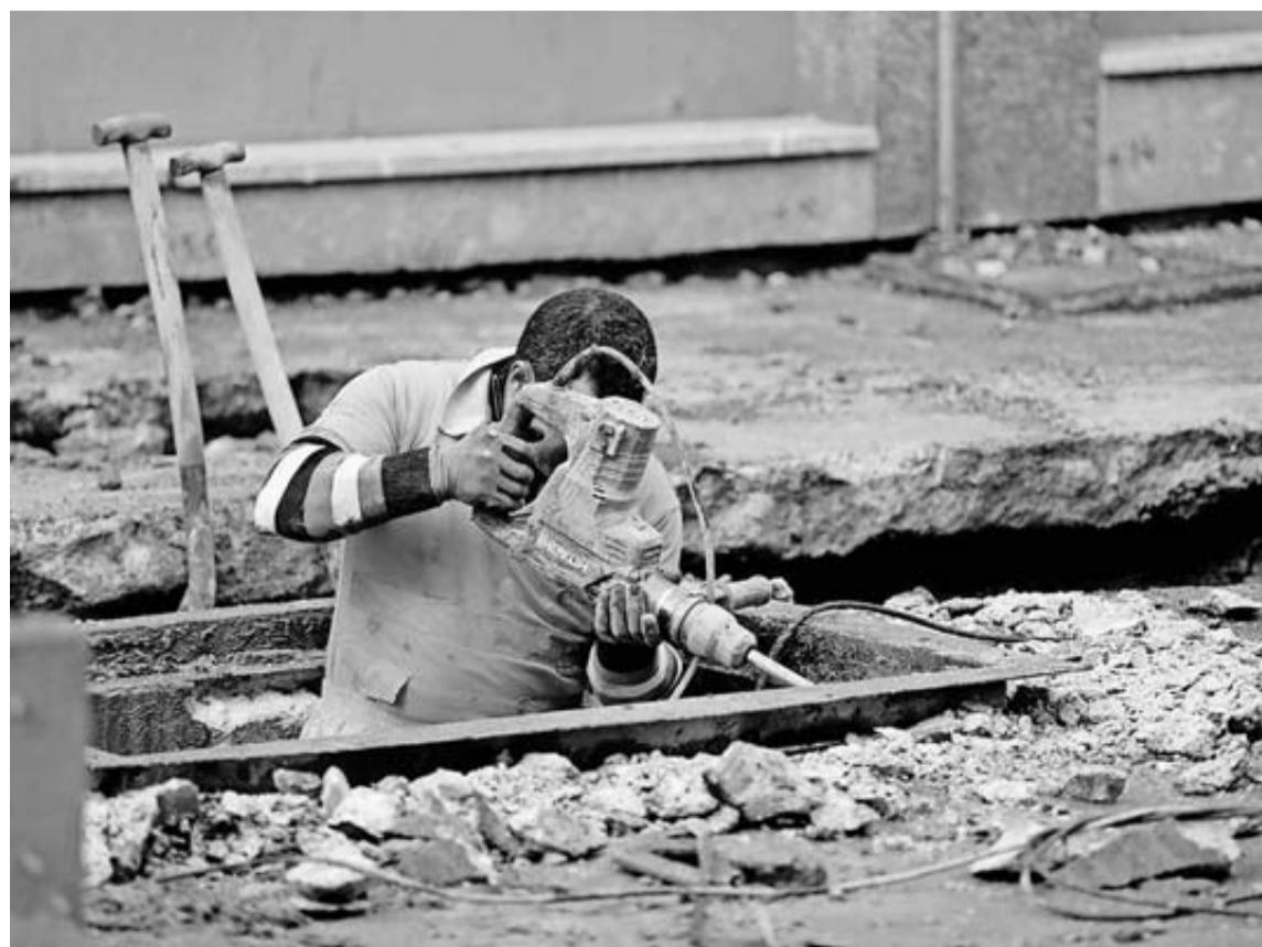
Un trabajador realiza obras en el asfalto de una calle.
