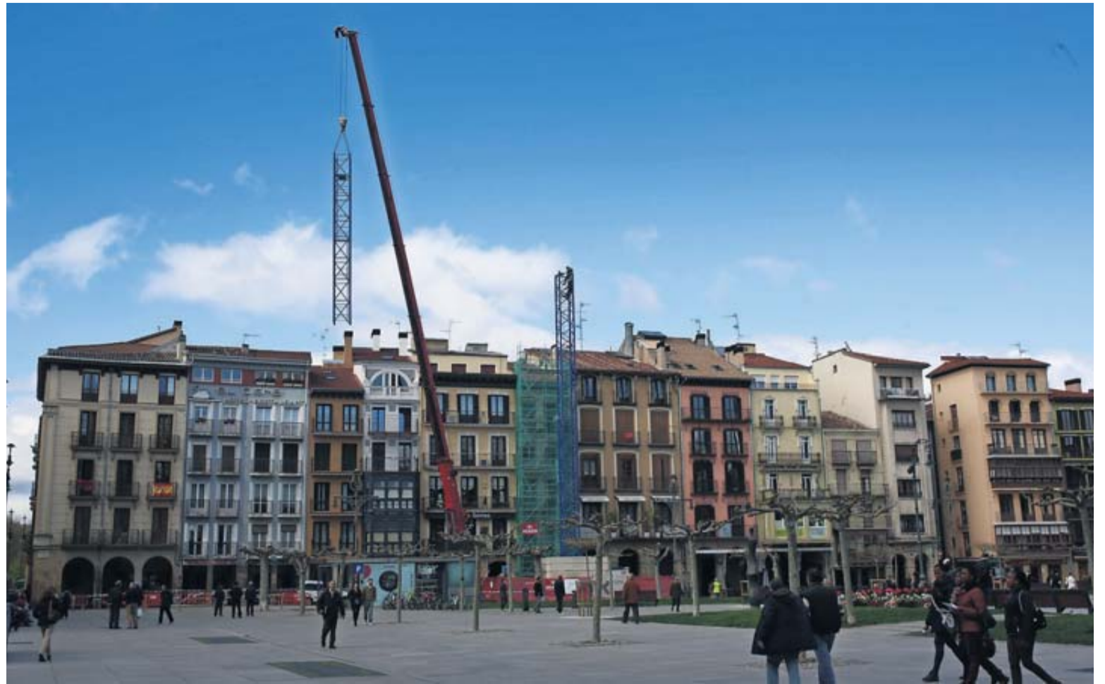
Montaje de grúas para la rehabilitación de un edificio de viviendas en la Plaza del Castillo.
