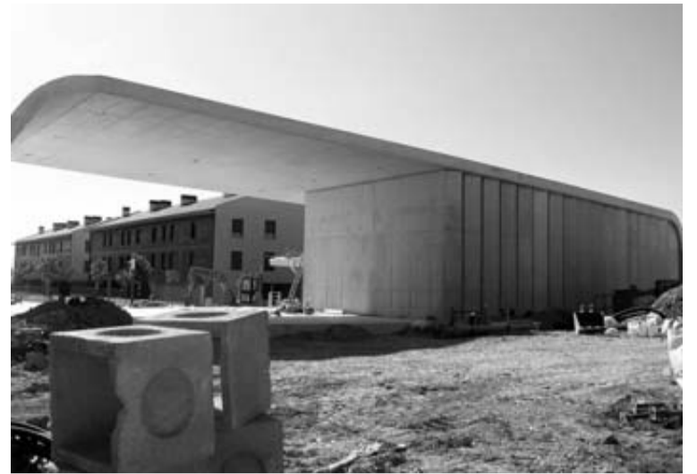
Vista del nuevo edificio que se construye en Cordovilla.
