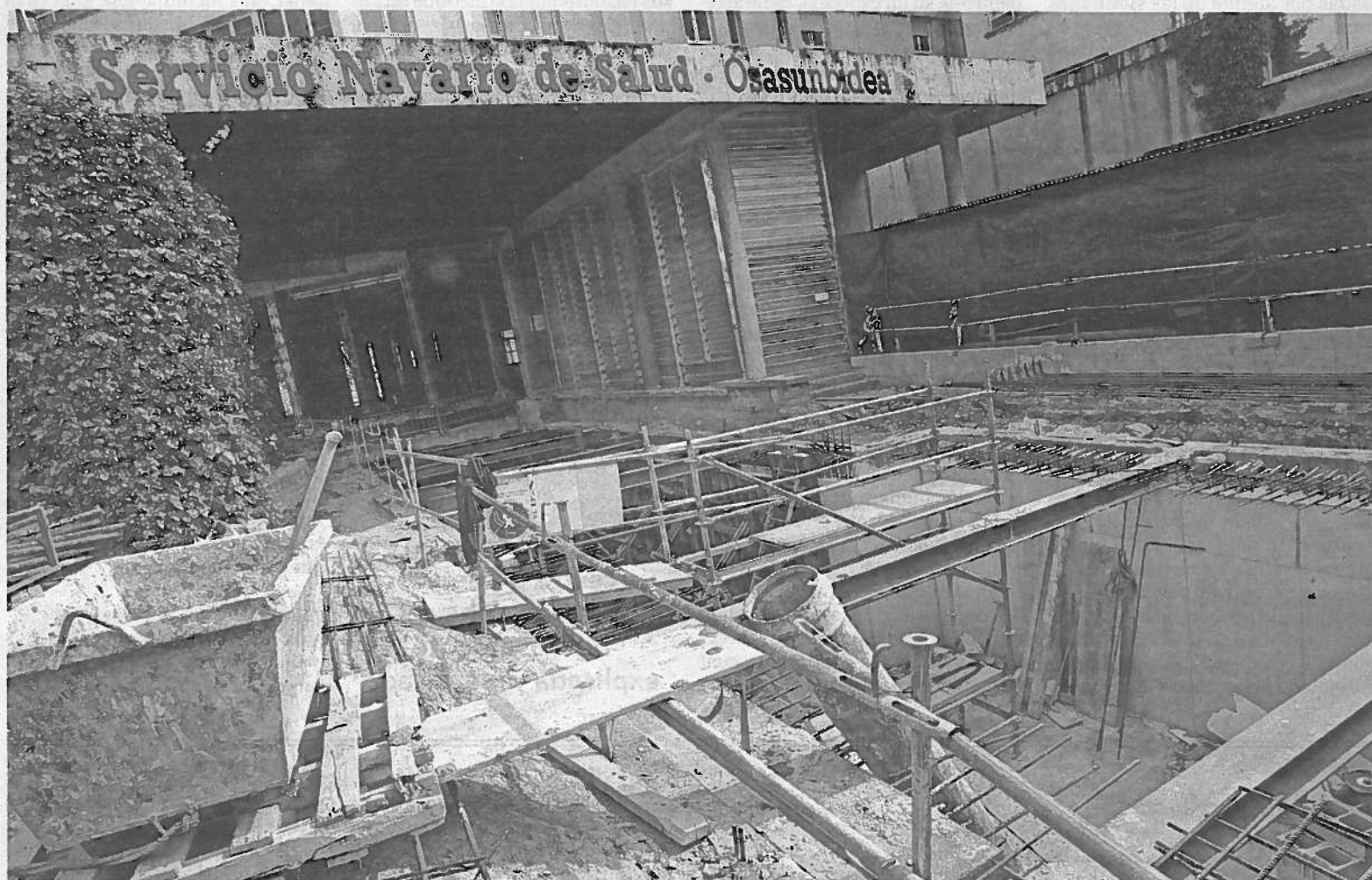
Obras de construcción de la galería subterránea que une el Hospital de Navarra con Virgen del Camino. FOTO: I. AGUINAGA
