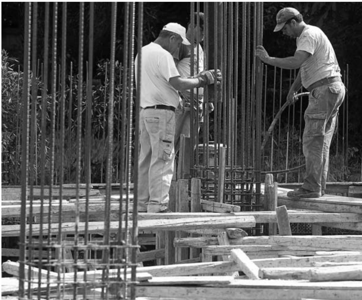
Obremos de la construcción en Atenas donde la crisis ha recortado la actividad del sector un 50%.
