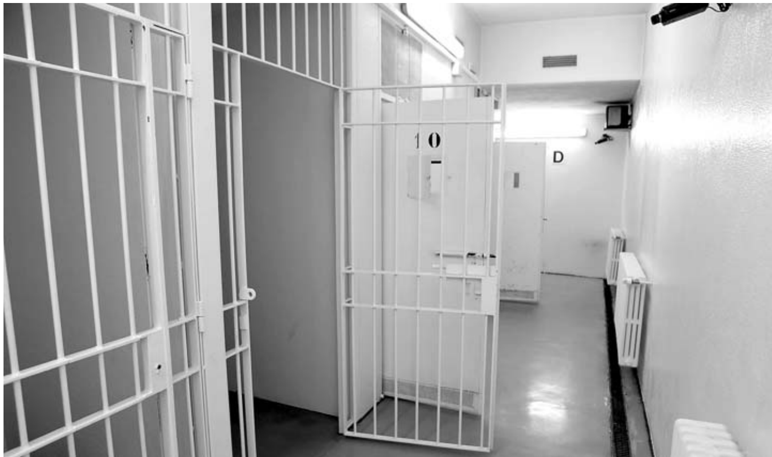
Acceso a una de las celdas o calabozos. Las cámaras están en el interior de cada una de las 13, en el techo, y también en los pasillos.
