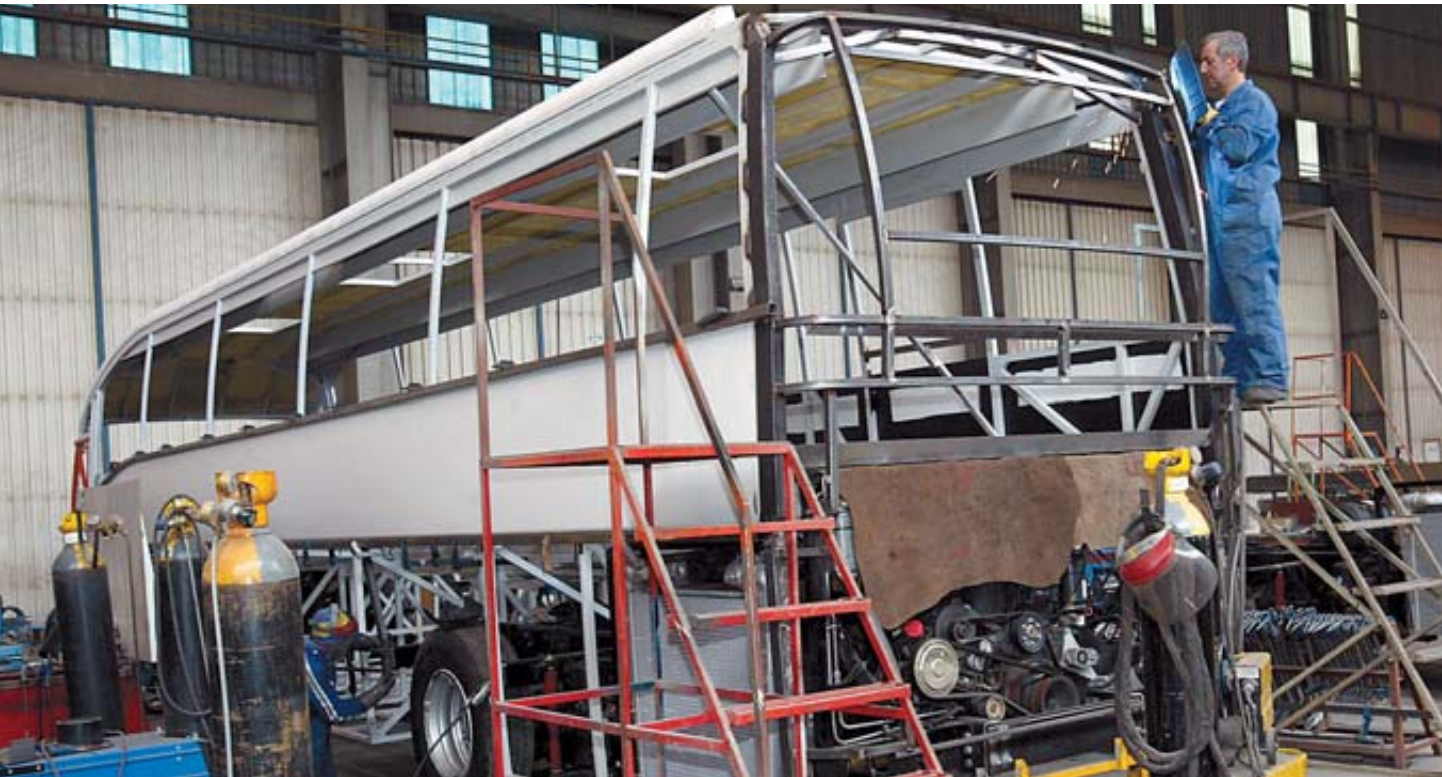
Trabajos de soldadura en el armazón de uno de los autobuses construidos en 2003. CORDOVILLA (ARCHIVO)
