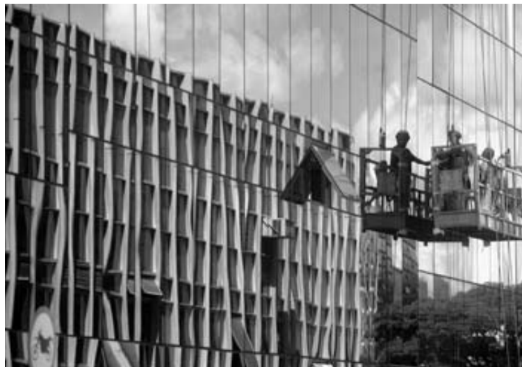
Dos operarios limpian la fachada de un edificio.
