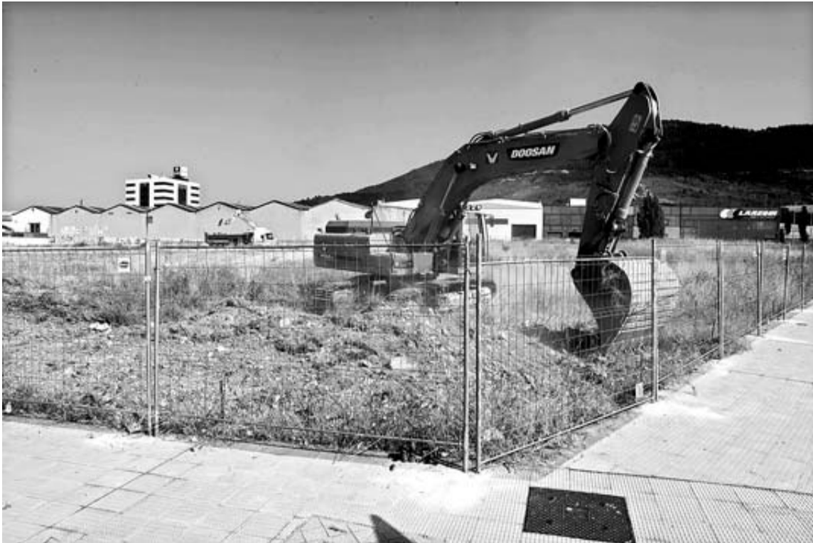
Las máquinas trabajan ya en el terreno que ocupará Mercadona en el polígono de Ansoáin. JESÚS GARZARON
