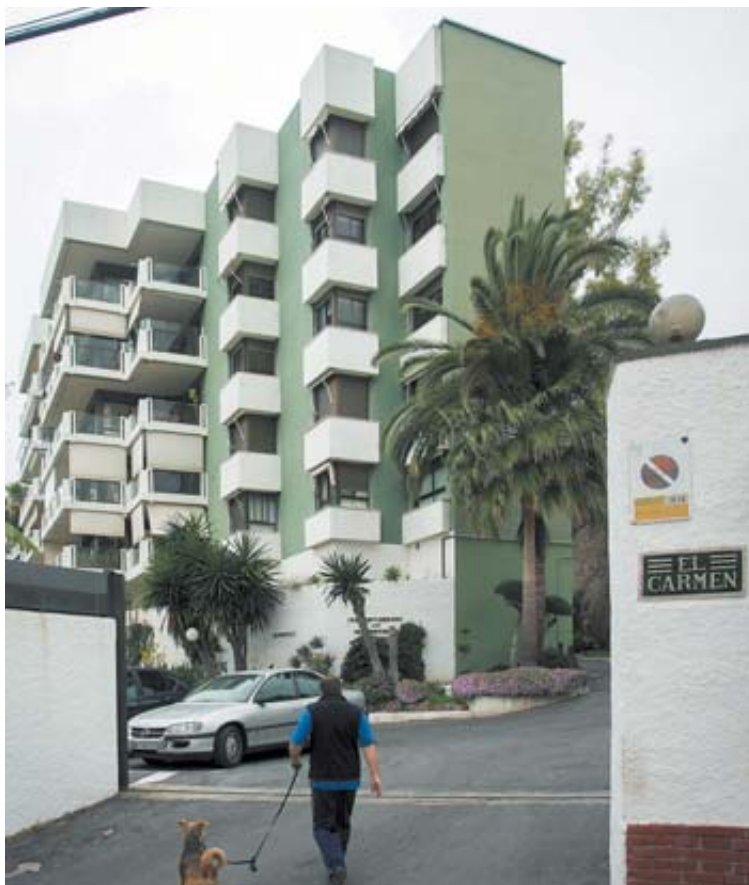
Fachada de uno de los inmuebles embargados en Málaga.
