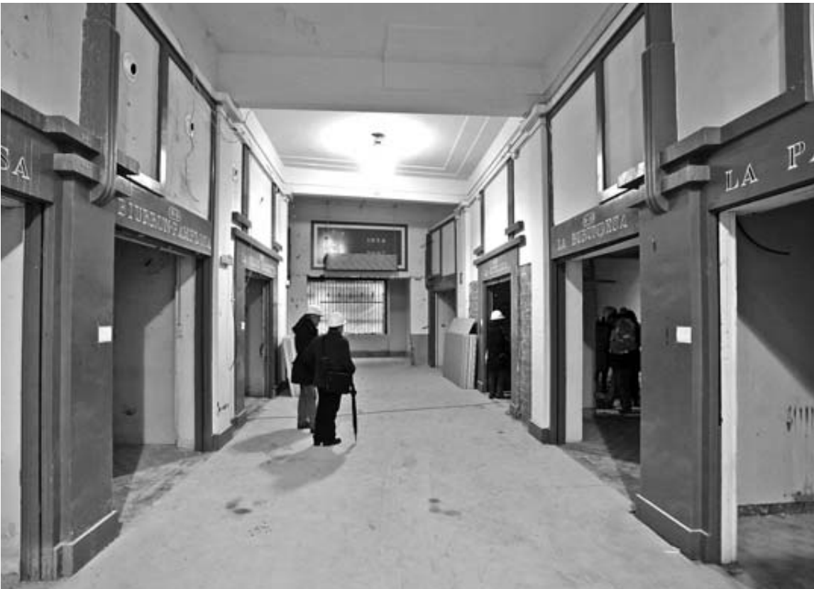
Imagen de las obras de acondicionamiento en la zona de taquillas.
