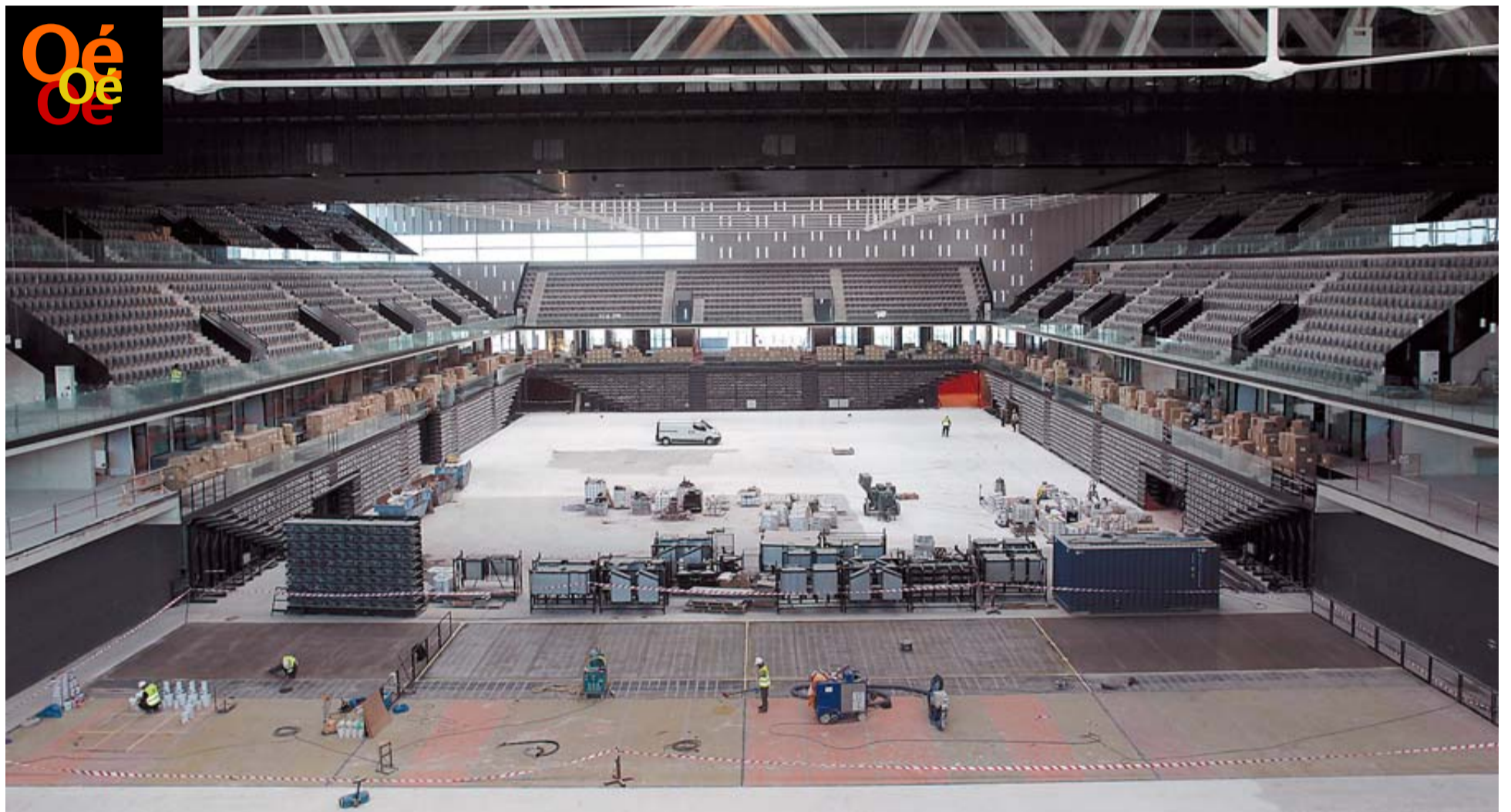
Una vista panorámica del interior del Navarra Arena. En primer plano el cofre que acoge las gradas retráctiles. Al fondo la pista central, donde caben 10.000 personas.
