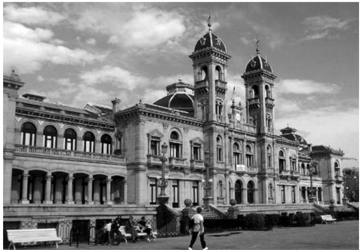
En la imagen, fachada del Ayuntamiento de San Sebastián.
