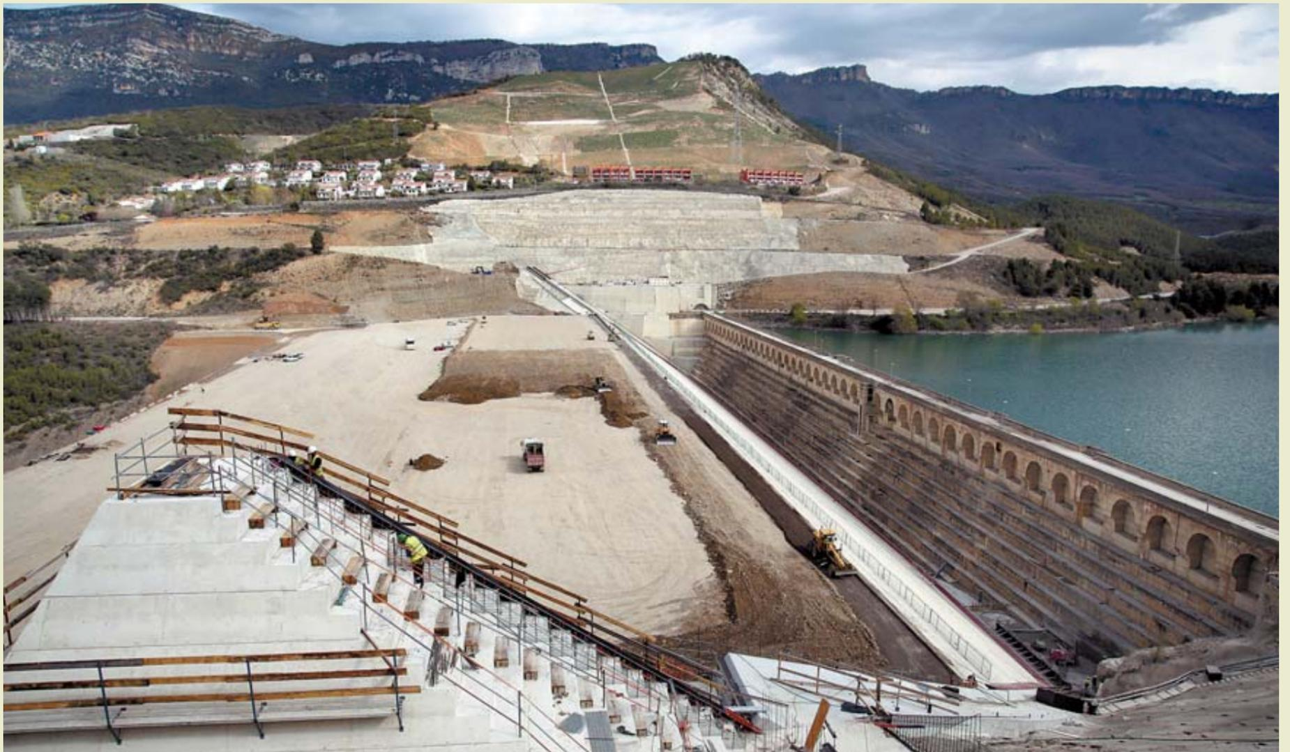
En la imagen se observa la ancha presa de materiales sueltos que se está construyendo y que ha alcanzado ya la altura de la antigua.
