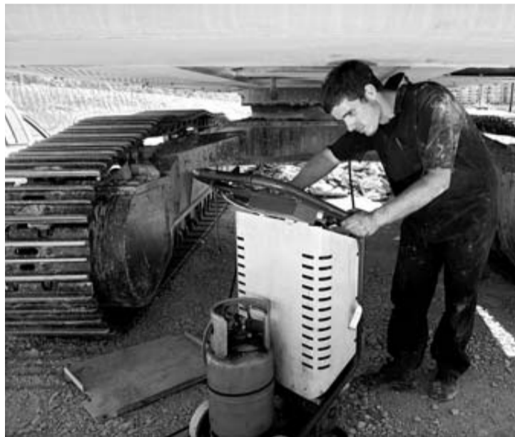
Iker Lizarraga Lazkano repara la ventilación de una excavadora. IBENÍTEZ
