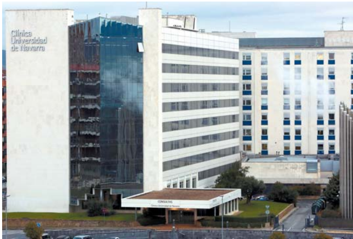
El edificio de la CUN, la Clínica Universidad de Navarra, en Pamplona.
