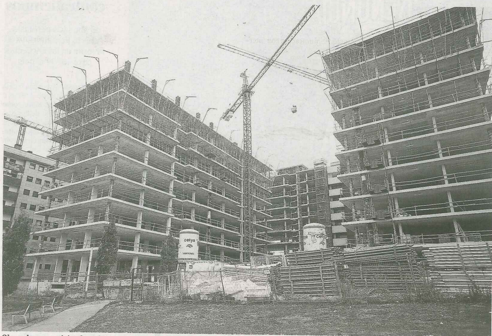
Obras de nueva vivienda en la zona de Erripagaña. Foto: Javier Bergasa
