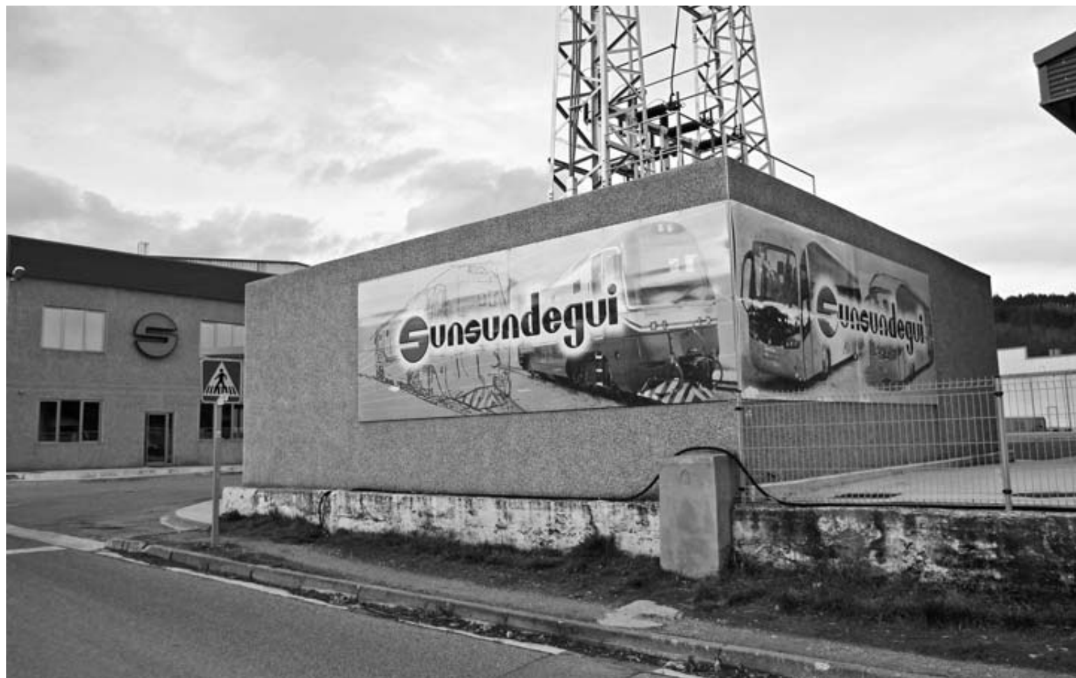
Imagen del acceso a las instalaciones de Sunsundegui, en el polígono Ibarrea de Alsasua.
