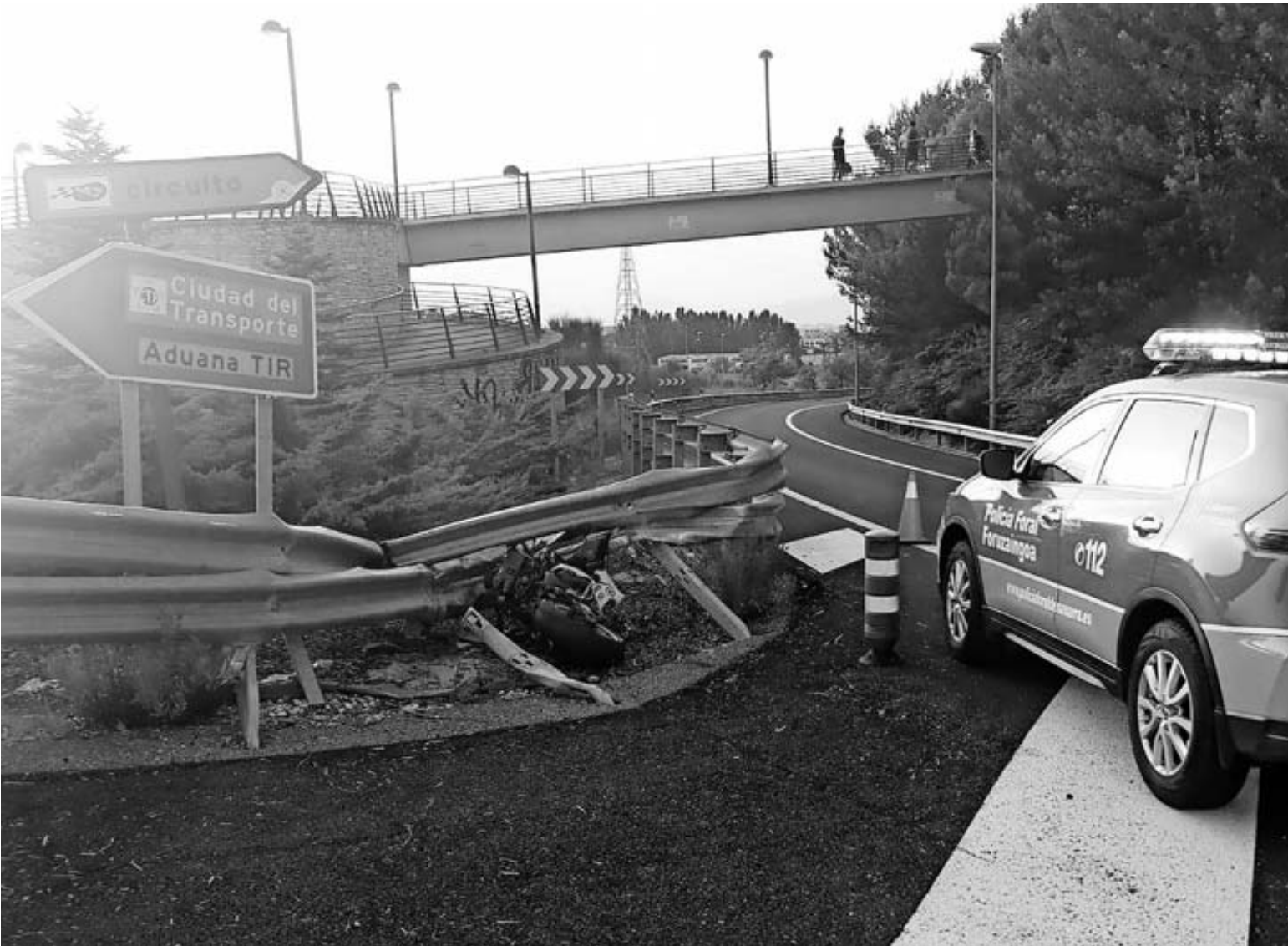
Lugar donde se produjo el accidente, con el punto del impacto en el carril de acceso a la AP-15 desde la Autovía del Pirineo.
