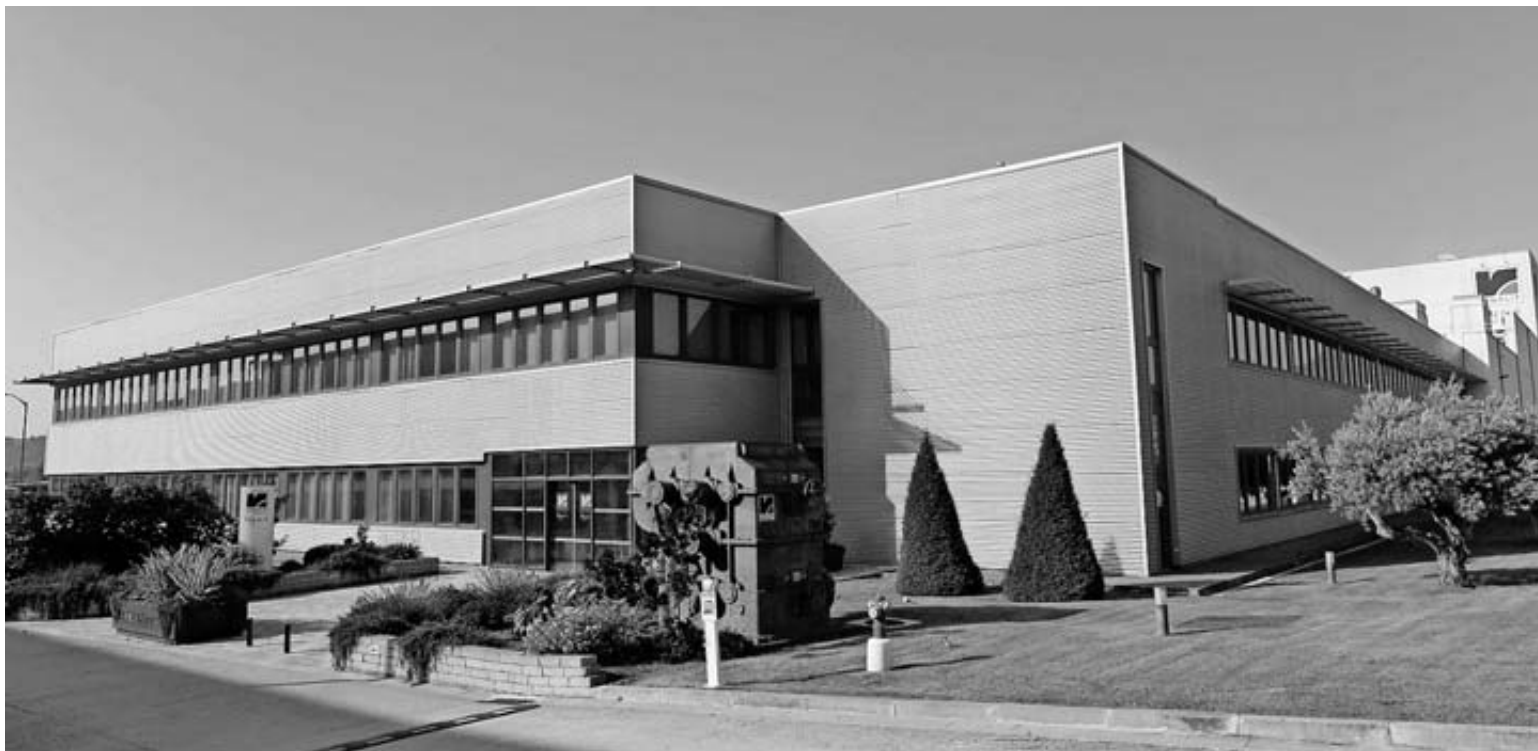
La planta de Renolit en el polígono San Miguel de Villatuerta.
