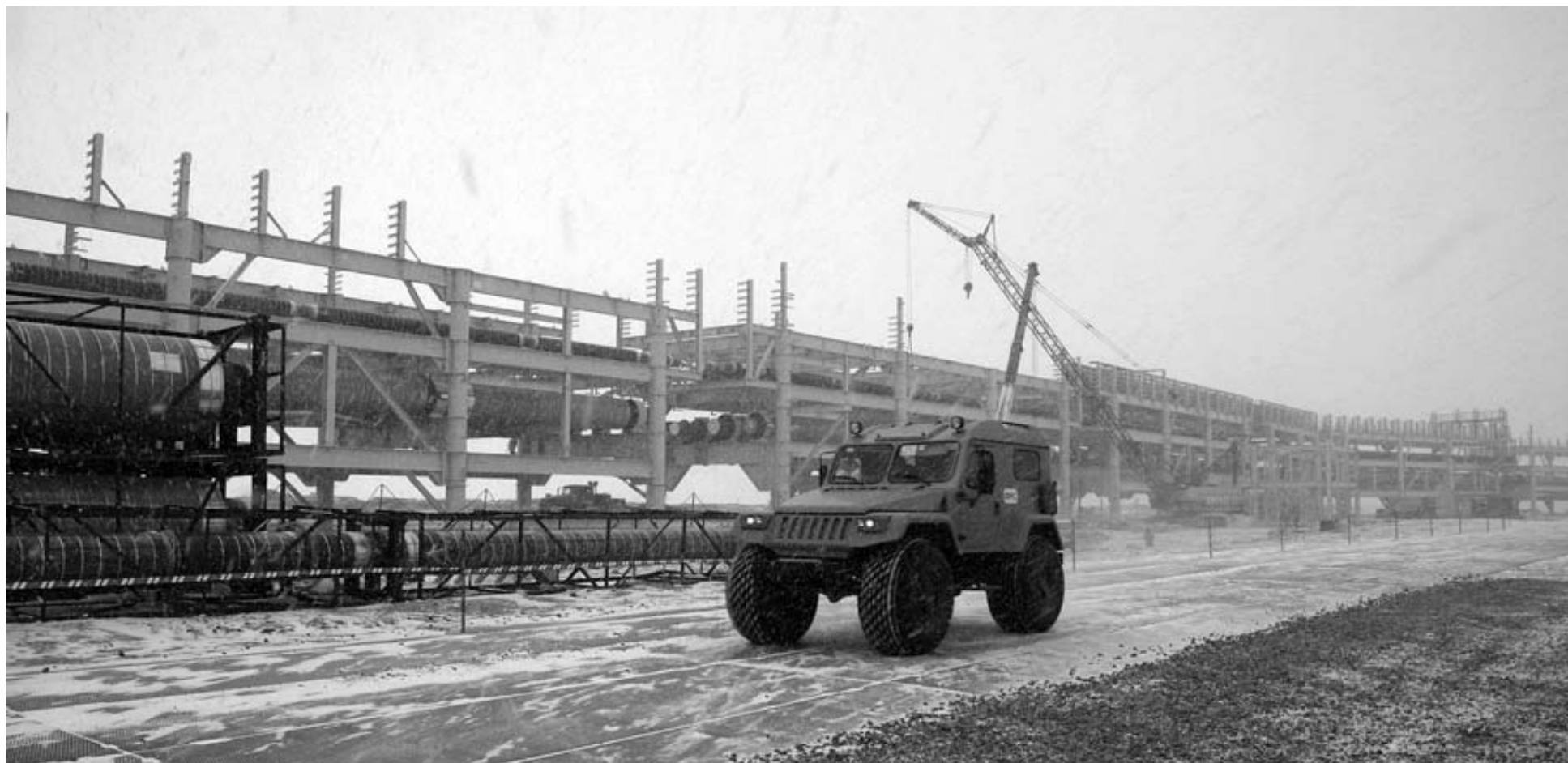
Las obras se realizan en condiciones climatológicas extremas.
