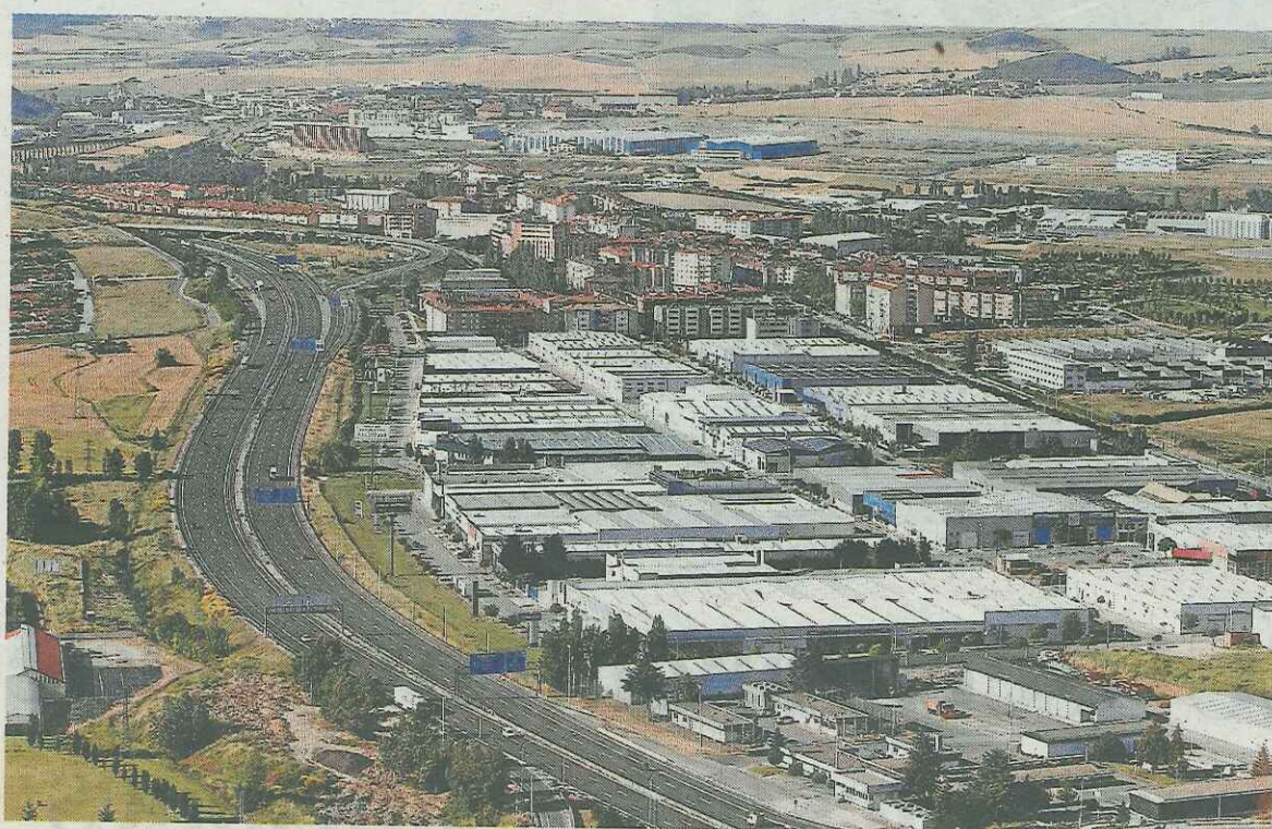
Polígono industrial en Noáin. Foto: Patxi Cascante
