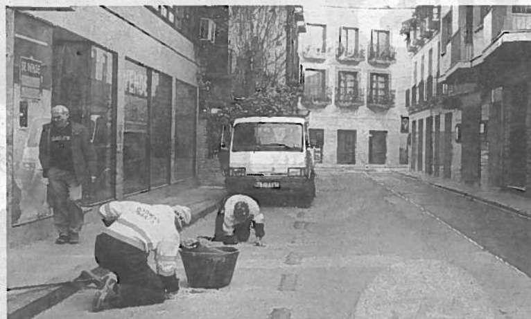
Dos operarios realizan obras de peatonalización en Barrio Verde. FOTO: C.J.
