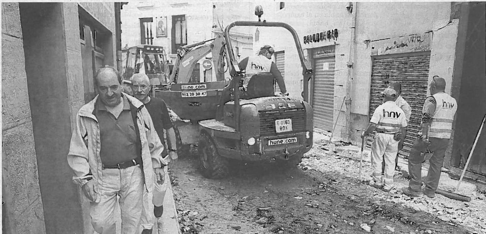
Obras de mejora en la calle Jarauta, que vuelve a quedarse sin fecha para su reurbanización completa. FOTO: JAVIER BERGASA
