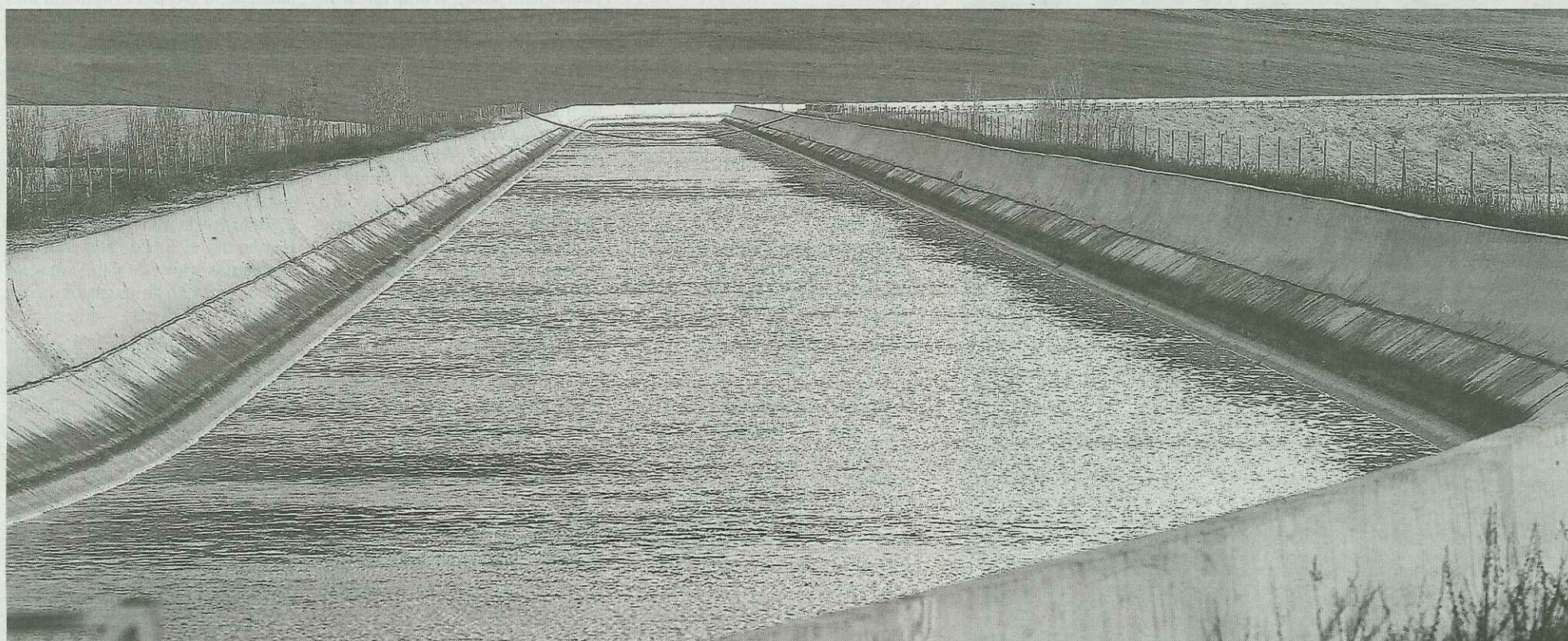
El Canal de Navarra, a su paso por Tiebas. Para seguir con esta infraestructura hasta la Ribera, se ha propuesto una tubería subterránea a diferencia de la primera fase. Foto: Javier Bergasa
