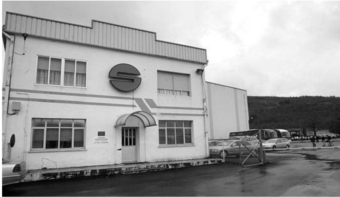
Vista exterior de las instalaciones de Sunsundegui, en la localidad de Alsasua.
