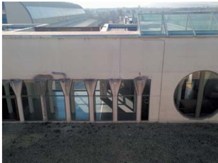
Vista de la cubierta del aula de la UPNA.
