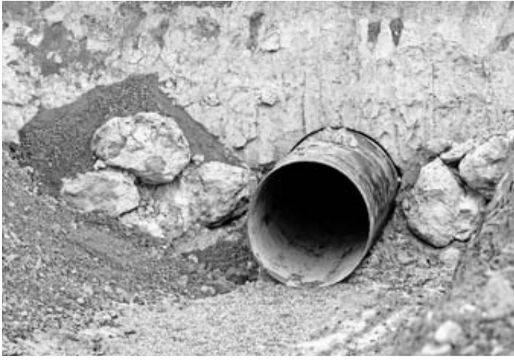
Imagen del Canal de Navarra en la ampliación de la 1ª fase. DN
