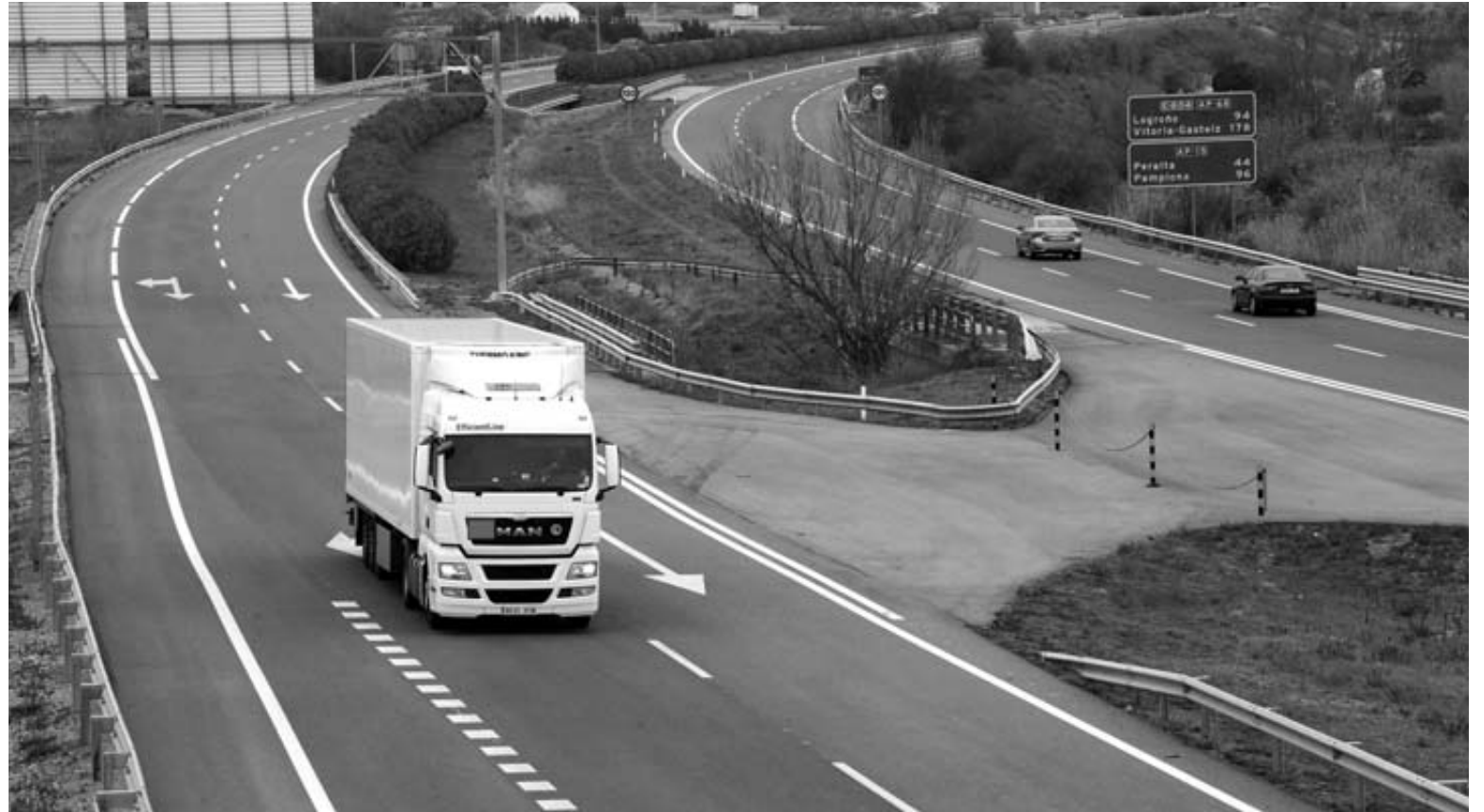
La AP-68 (Bilbao-Zaragoza) a su paso por Tudela, autopista que gestiona Avasa, sociedad propiedad de Abertis.
