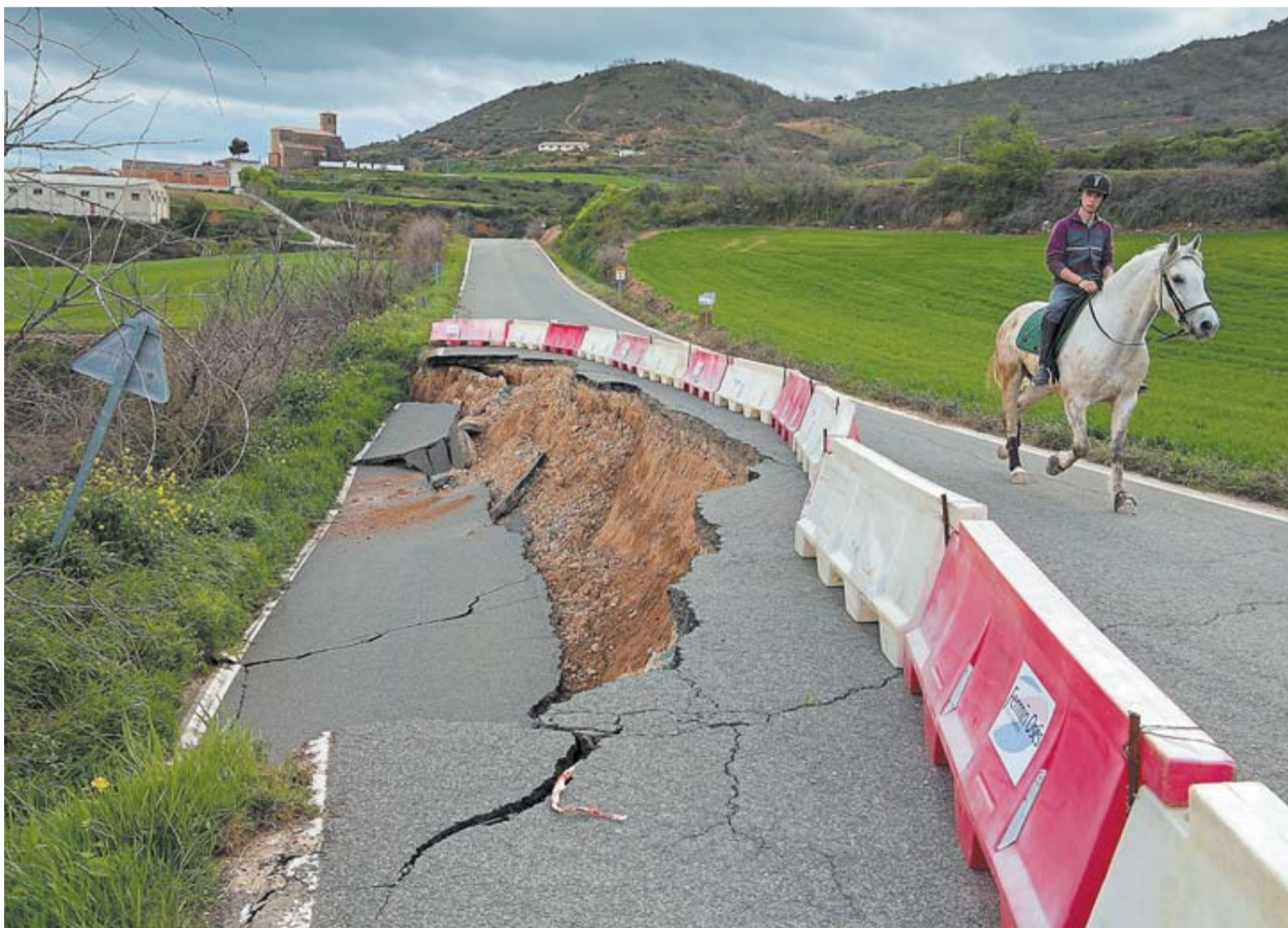
Estado que presenta la carretera que une en Tierra Estella las localidades de Muniáin y Morentin.
