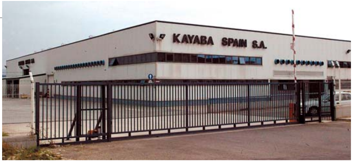
Edificio de Kayaba, en el polígono de Orkoien.
