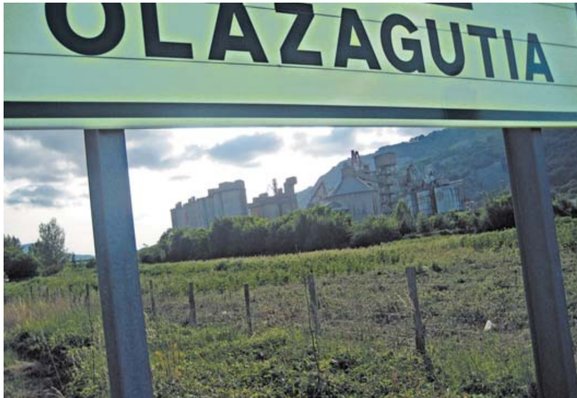
Al fondo, aspecto parcial de las instalaciones de Cementos Portland en Olazagutía.
