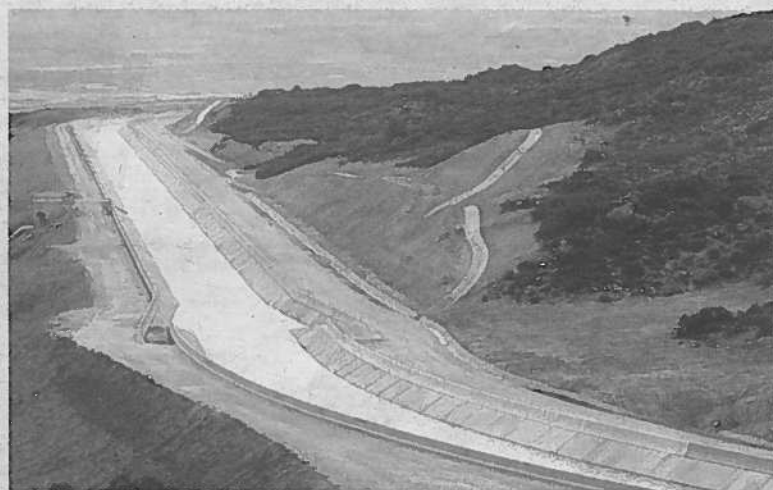
La primera fase del Canal de Navarra está concluida. FOTO: PATXI CASCANTE
