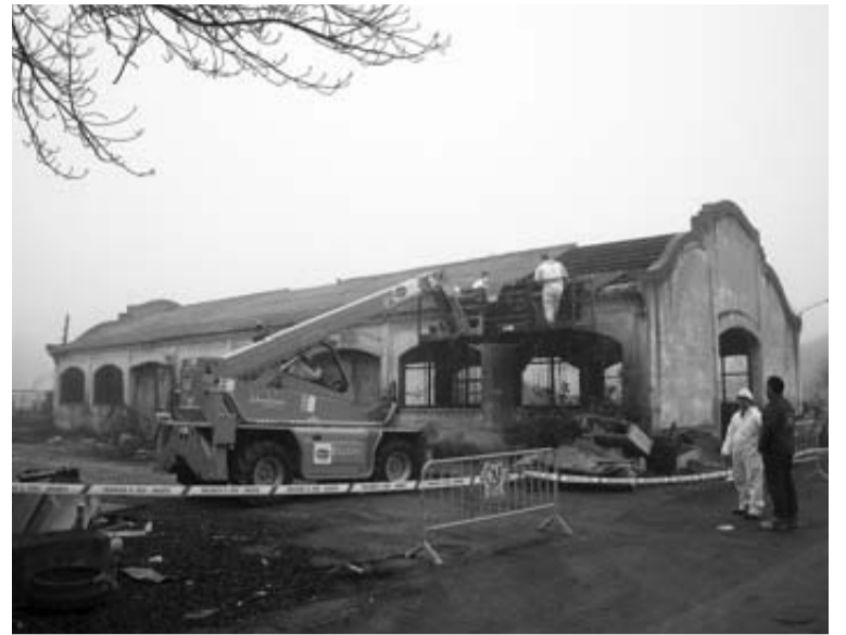
Derribos en la calle Sadar, realizados por Excavaciones Olloquiegui. DN
