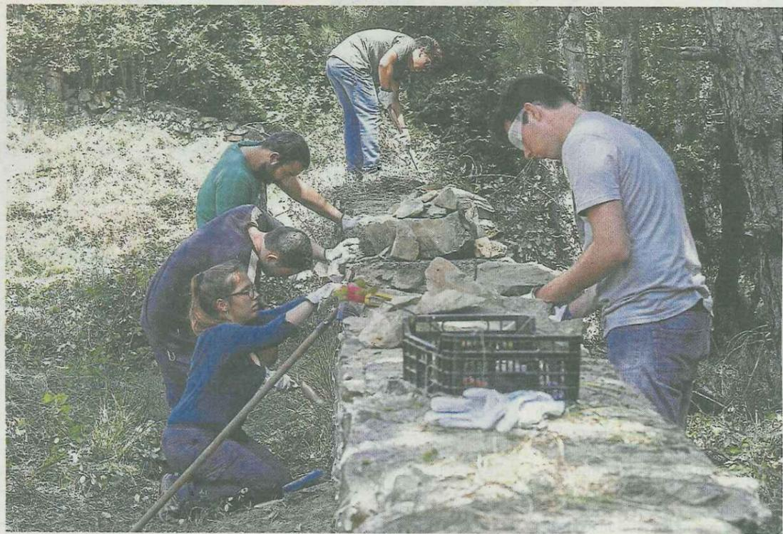
Labores de reparación de uno de los muros que limitan el cementerio.
