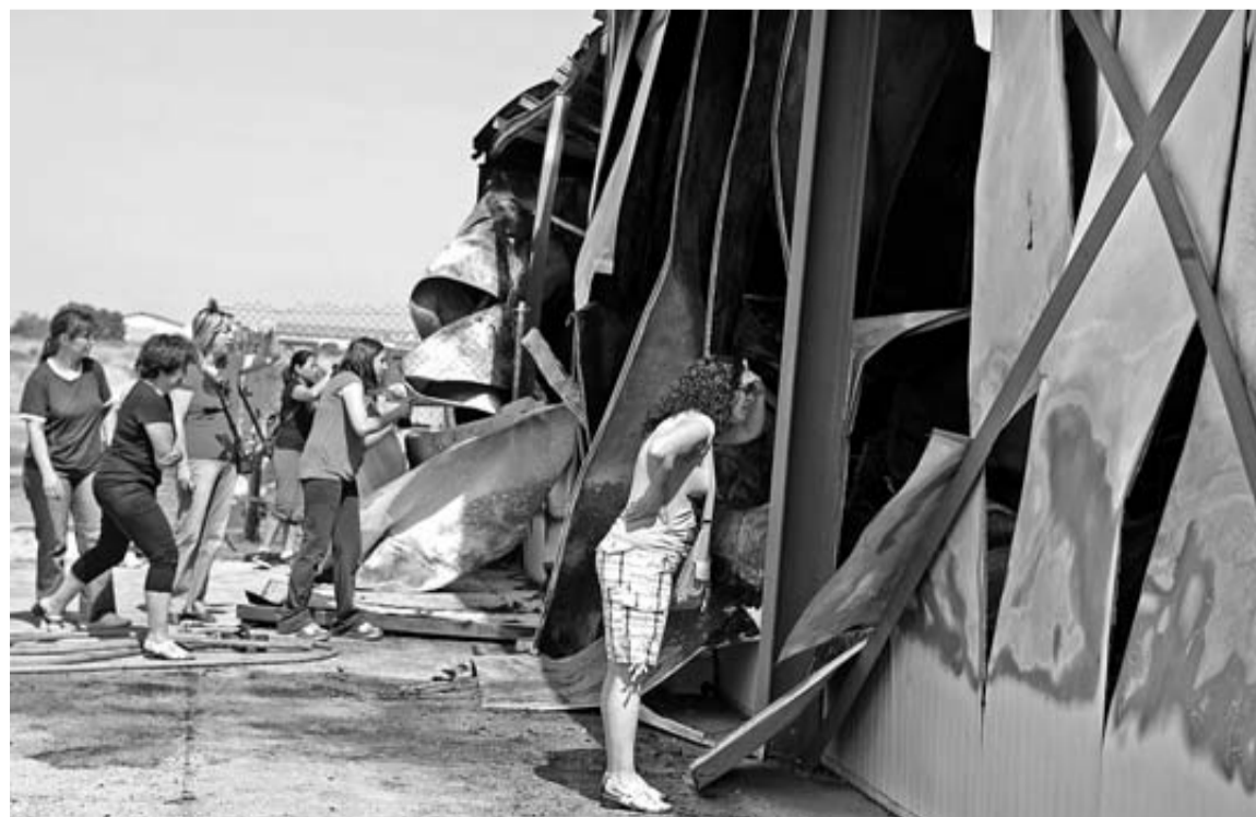
Varias trabajadoras observan los daños que provocó el incendio en las instalaciones.
