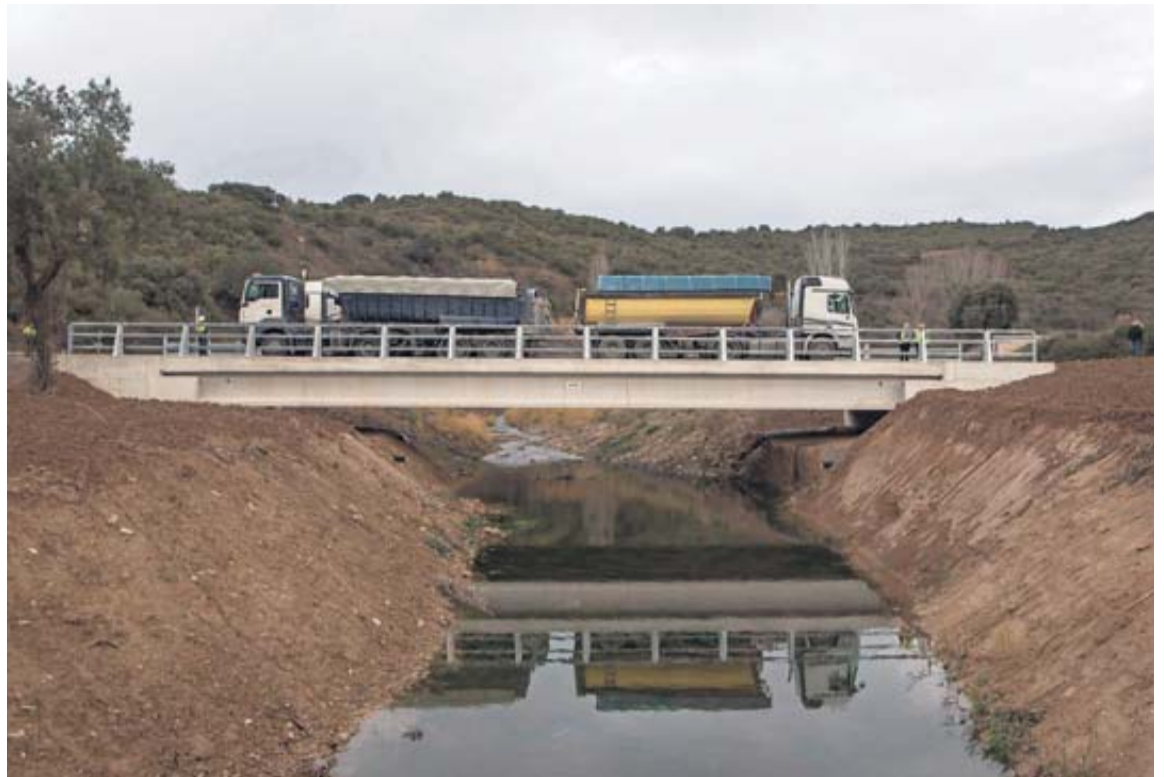
El puente de Sánsoain con los cuatro camiones de la prueba de carga.
