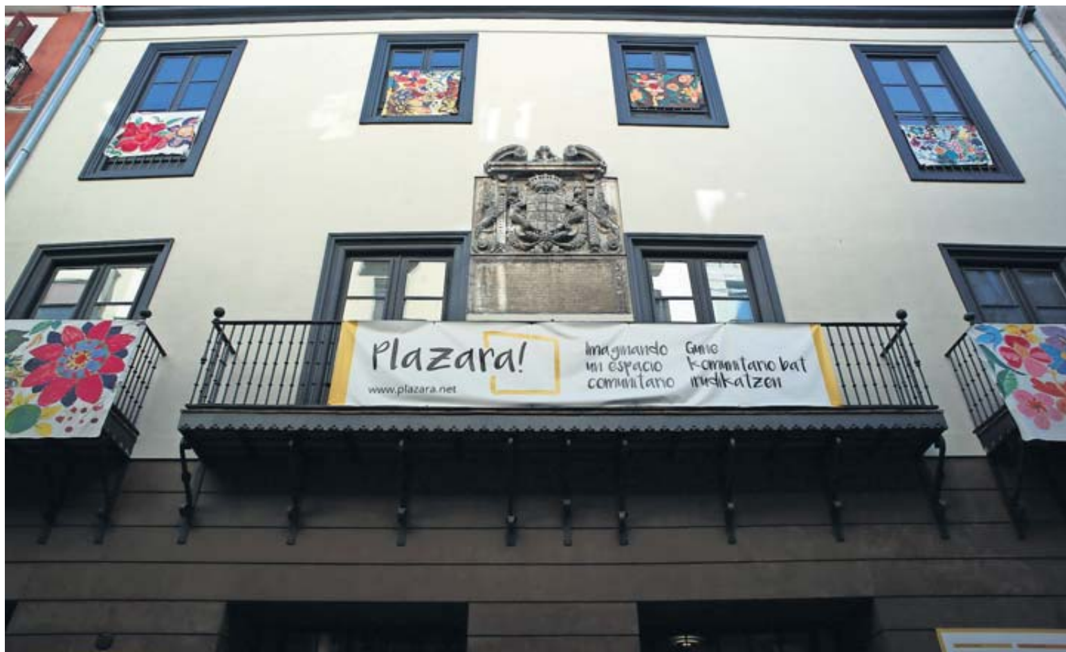
Las obras en el palacio Redín y Cruzat, en la calle Mayor, se adjudicaron 24 días después de haber finalizado el plazo máximo permitido. J.C.CORDOVILLA
