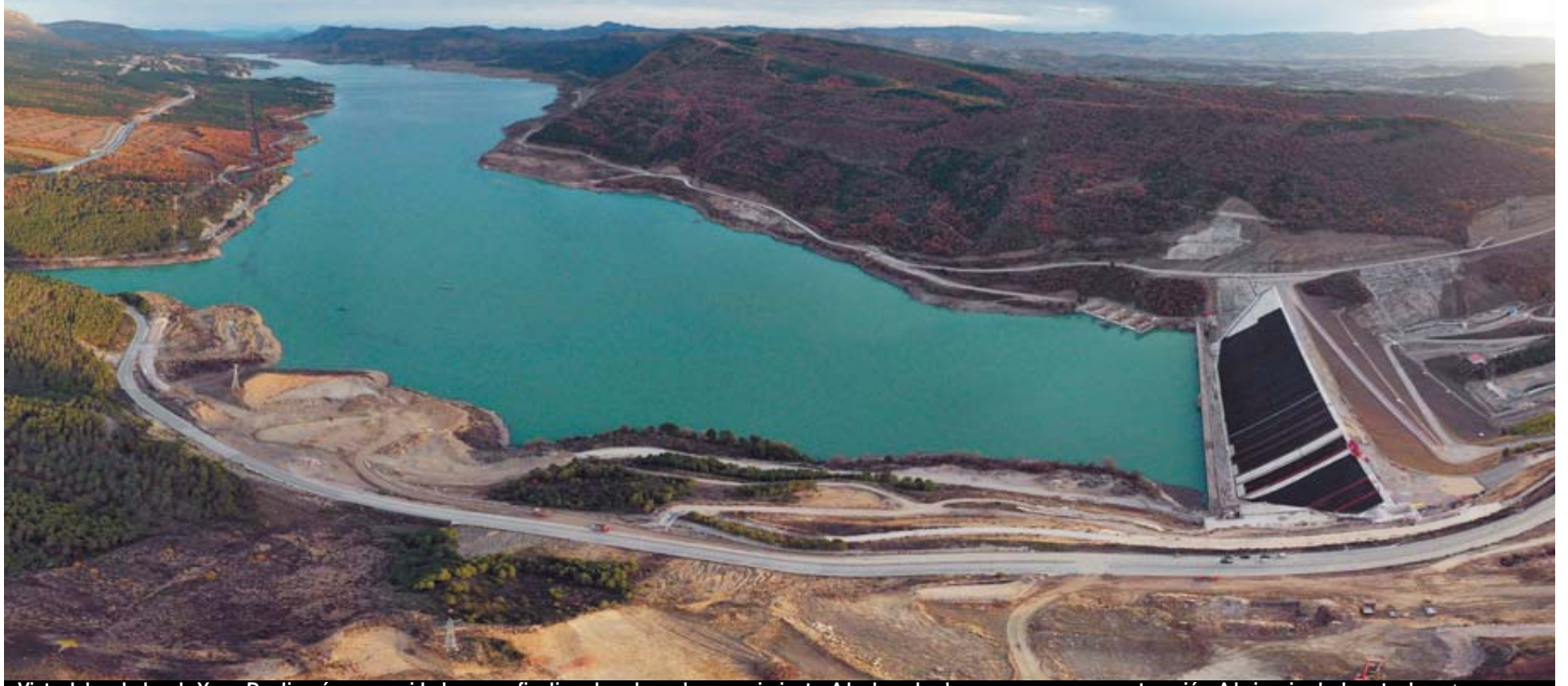
Vista del embalse de Yesa. Duplicará su capacidad una vez finalicen las obras de recrecimiento. A la derecha, la nueva presa en construcción. A la izquierda, la actual. JESÚS DIGES (EFE)
