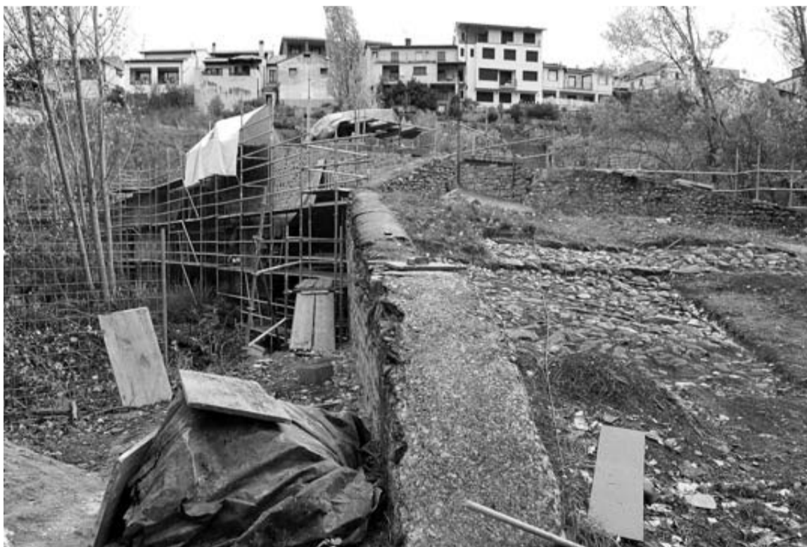
Trabajos de restauración en el puente de las Cabras de Lumbier.
