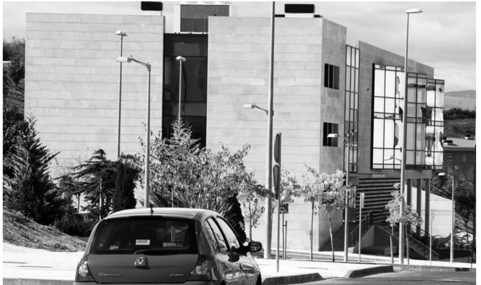
Una vista del centro residencial Félix Garrido ubicado en Sarriguren, en una imagen tomada recientemente.
